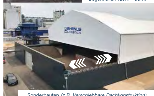
Sonderbauten (z.B. Verschiebbare Dachkonstruktion)
