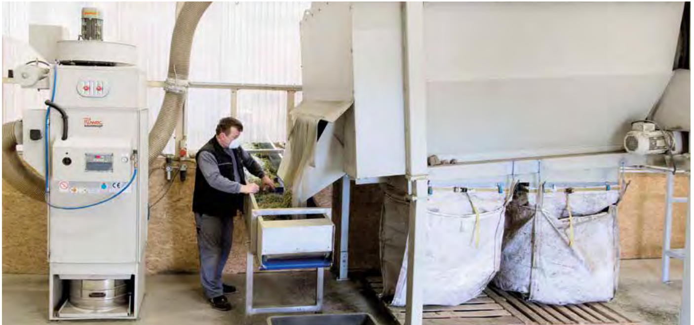
Absaugen direkt an der Entstehungsstelle: Einsatzbeispiel eines DS6-Entstaubers
