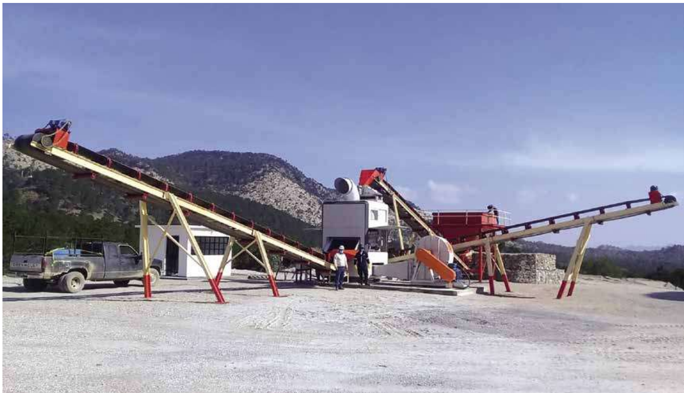
Eine Barit-Aufbereitungsanlage (Bariumsulfat \text{BaSO}_4 ) in Mexiko
