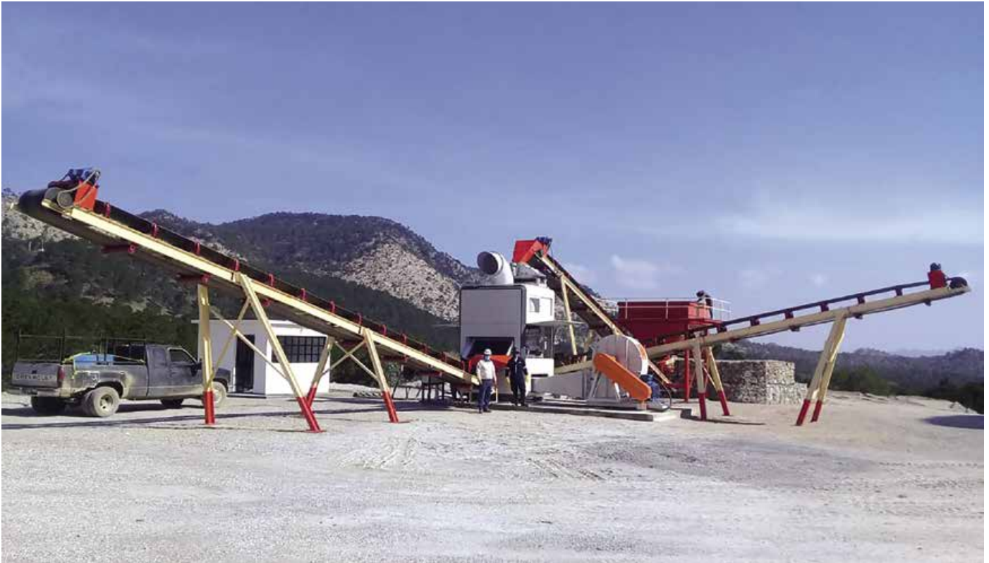
Eine Barit-Aufbereitungsanlage (Bariumsulfat \text{BaSO}_4 ) in Mexiko
