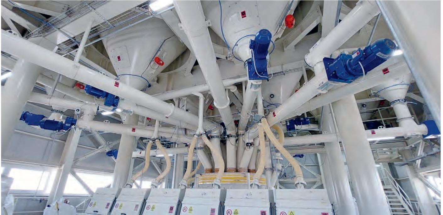
Rohrförderschnecke und Drehklappe VFS
