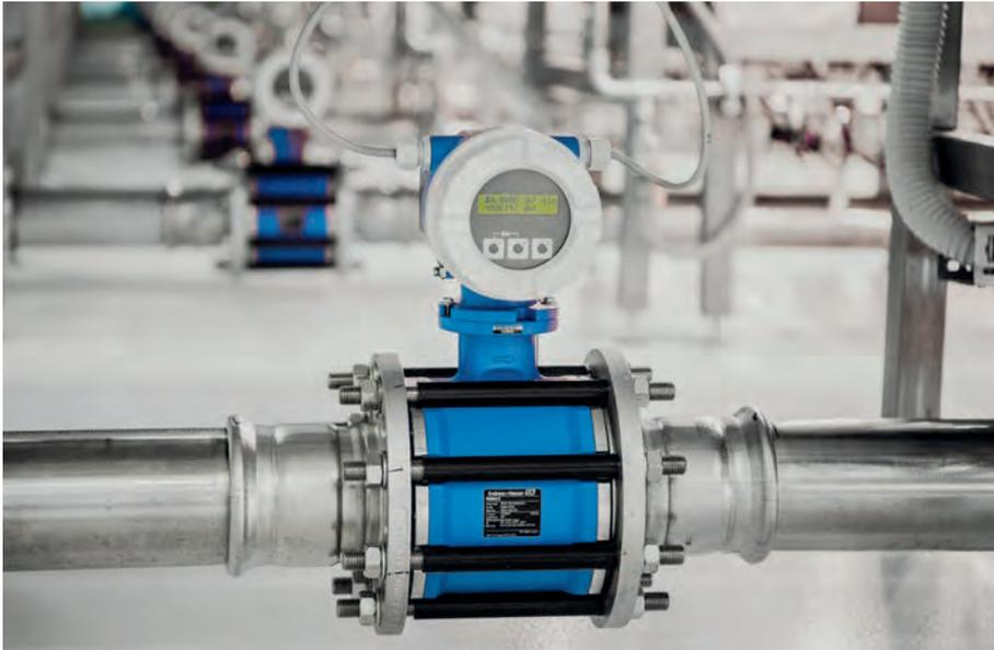
Die Fließgeschwindigkeit wird mit dem magnetisch-induktiven Durchflusssensor Promag 10D erfasst.
