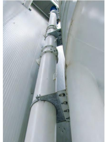
*Vertikale Förderschnecke in einem Zementwerk*
