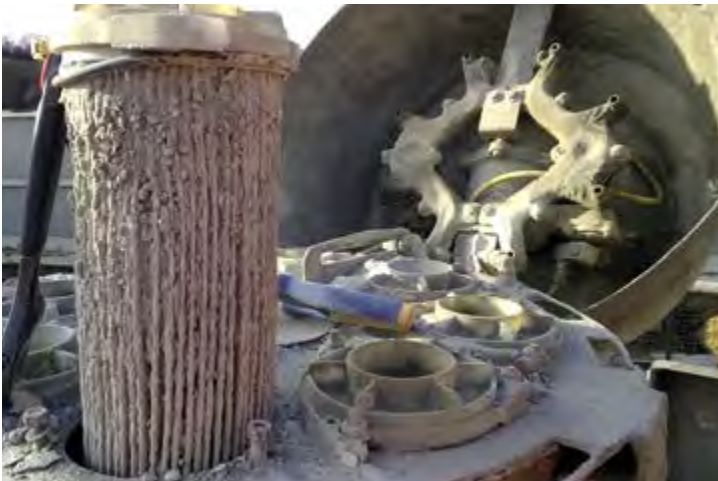
Verstopfte Filterkartusche – bedingt durch mangelnde Wartung
