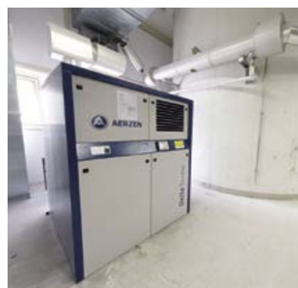
Die Delta Screw Einheiten vom Typ VM21 liefern einen Volumenstrom bis 1.200 Kubikmeter in der Stunde
