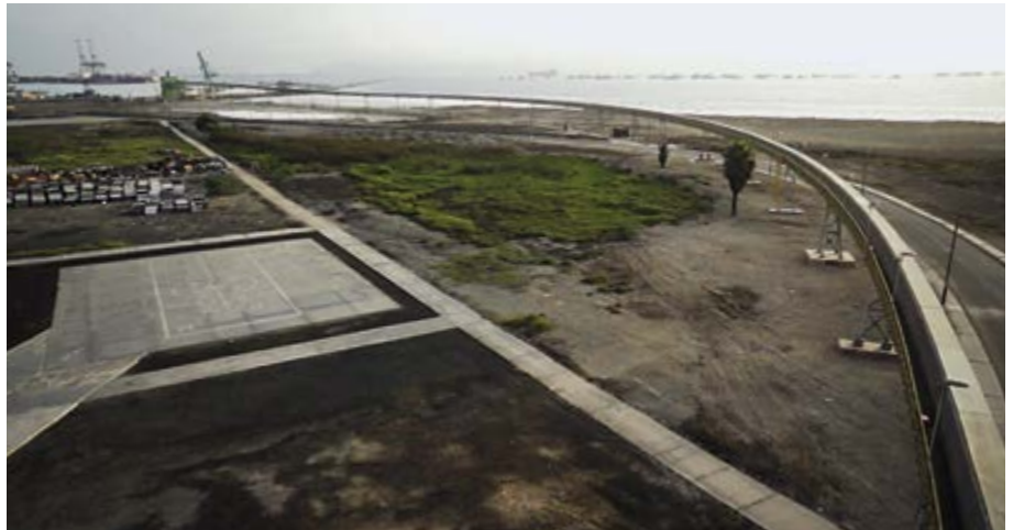
Der Pipe Conveyor passiert den Hafen: Dies ist der letzte Kurvenabschnitt vor dem Umschlagsturm zum Hafenterminal
