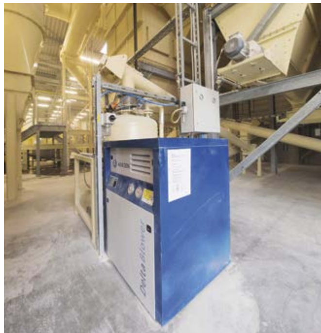
AERZEN-Technik kommt bei Knauf ebenfalls zum Einsatz, um Schleifstaub zurück in die Rohstoffaufbereitung zu transportieren
