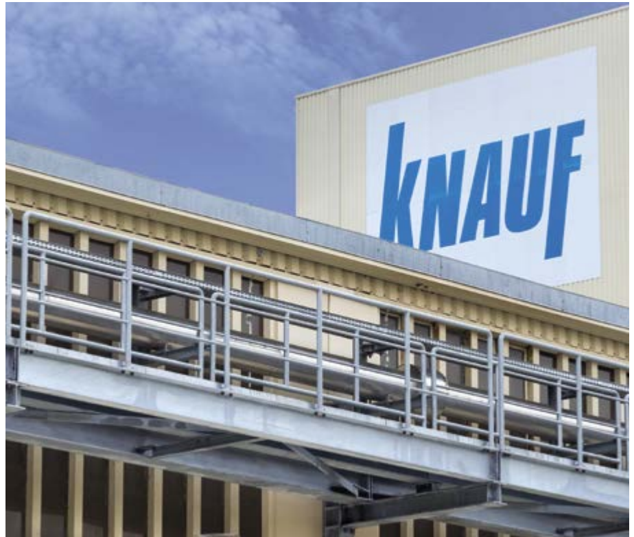
Über eine eigens gebaute Rohrbrücke wird die Faserplattenproduktion vom Gipswerk aus mit Stuckgips versorgt
