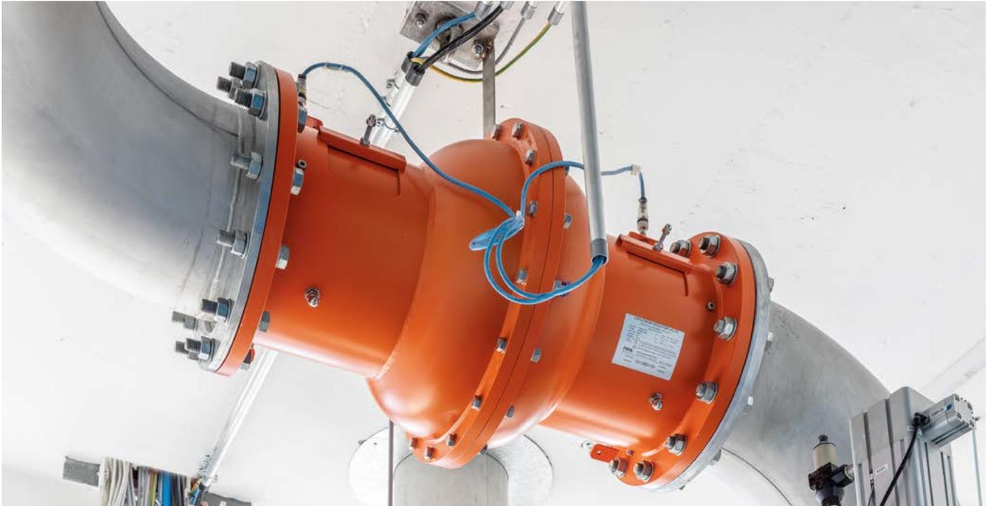
*VENTEX® Explosionsschutzventil aus der Schweiz*
