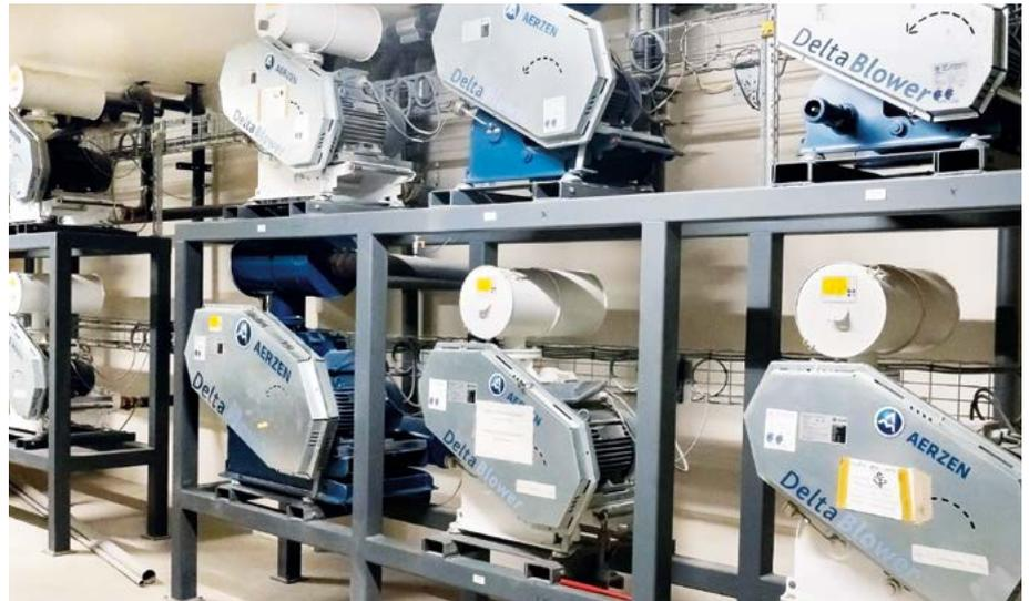
*Insgesamt 21 AERZEN Drehkolbengebläse vom Typ Delta Blower halten die Flockenproduktion am Laufen (Bild: AERZEN)*
