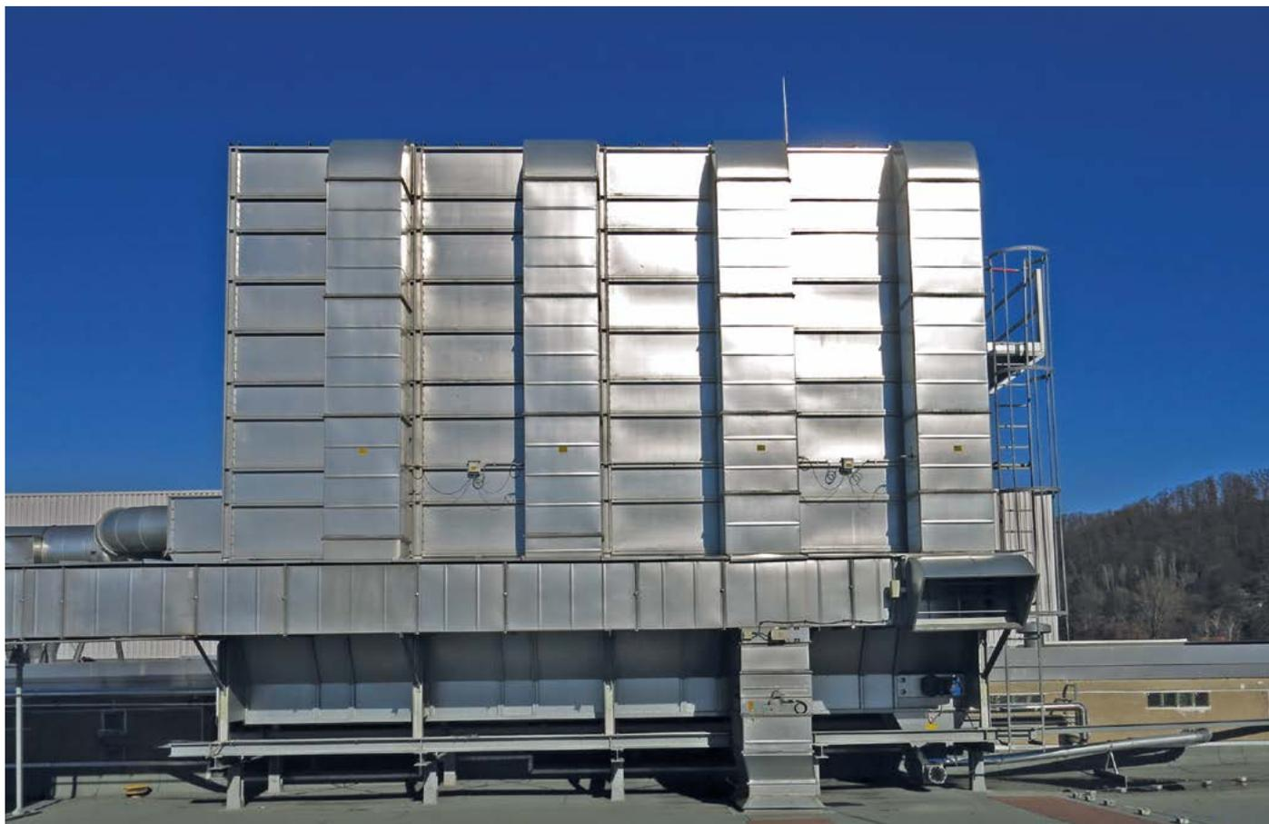
*Lückenlos werden Zündpotenziale in allen Bereichen erkannt: in der Absaugung vor dem Eintrag, im Filter selbst und ebenso in der Abluft*
