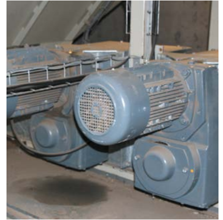
Innen verbaute Getriebemotoren in Ex-Schutz-Kategorien ATEX-Zone 22 oder ATEX-Zone 21
