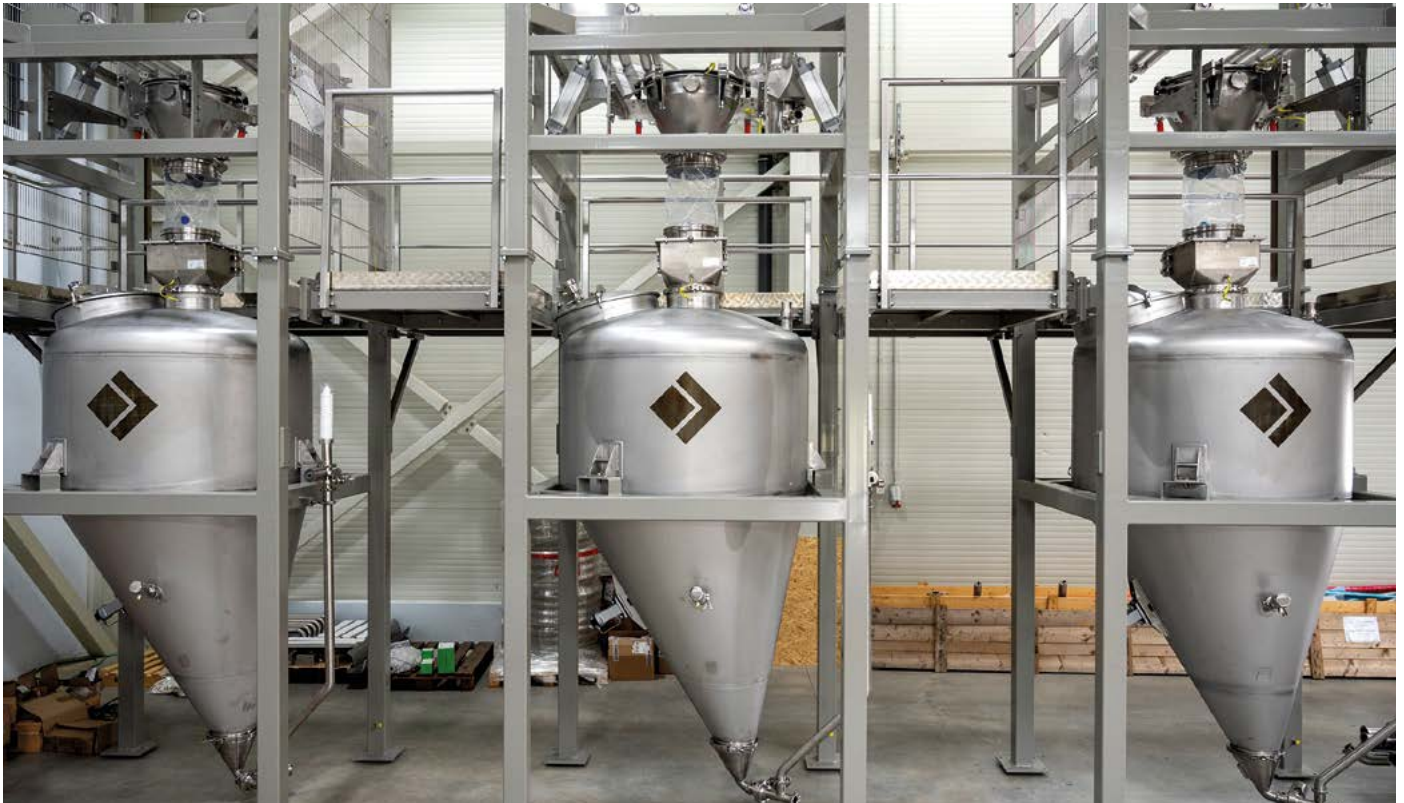
Die Big Bag-Entleerung in einer automatisierten Kombistation
