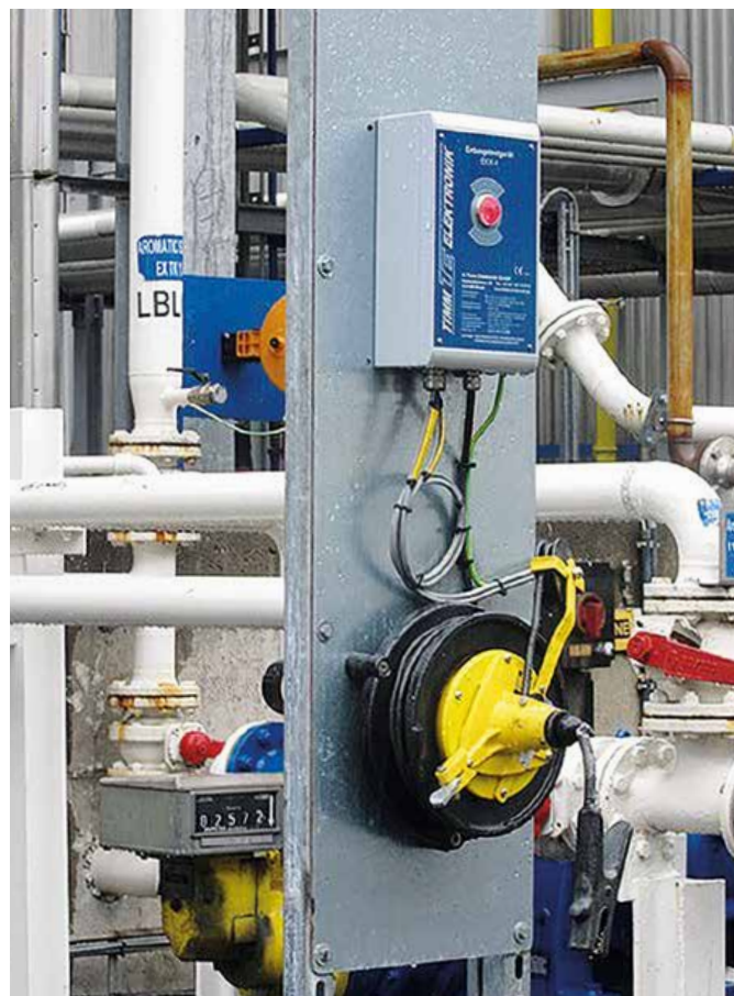
TIMM EKV-4 Erdungsgerät mit Kabelaufroller
