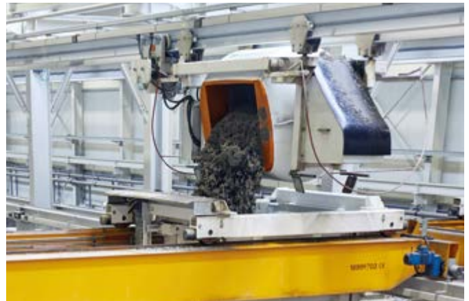
Drehkübel, beschichtet mit Kobaflex V80 im Betrieb
