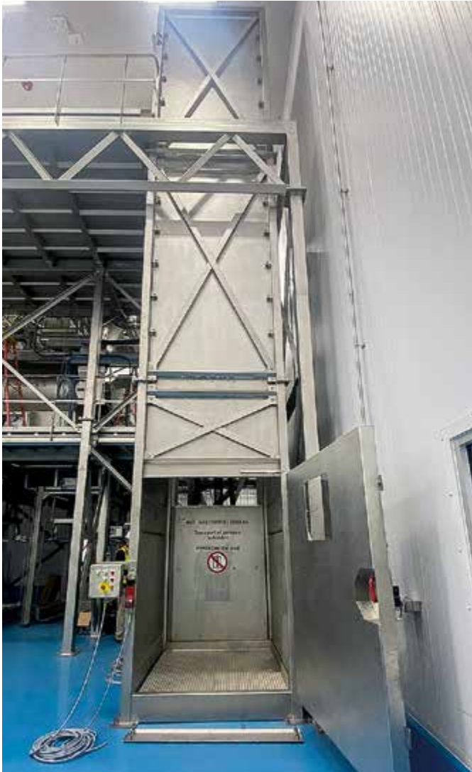
Ein vollständig aus Edelstahl gefertigter Warenaufzug für hygienische Produktionsumgebungen
