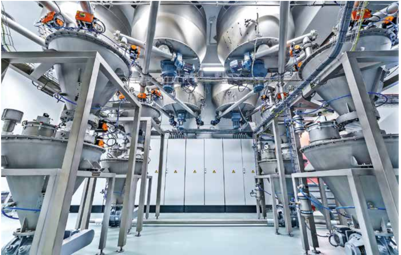
Automatische Mittelkomponentenanlage mit Wiege- und Fördersystem
