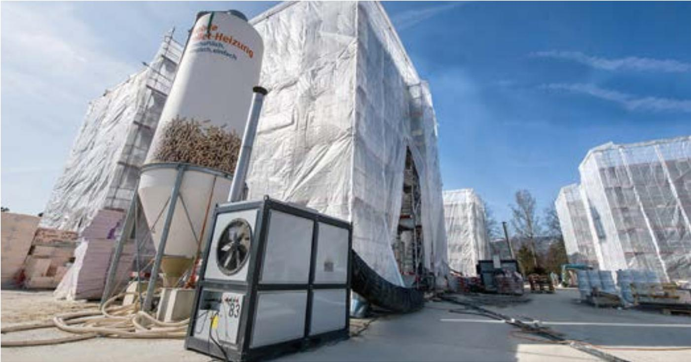
Mit den autarken IoT-Füllstandsensoren VEGAPULS Air lassen sich mobile Baustellenheizungen jederzeit exakt überwachen – für eine planbare, effiziente Versorgung und spürbare Einsparungen
