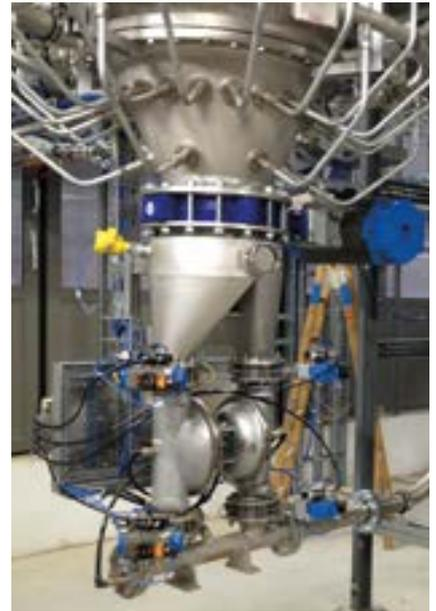
**DASAG-Pulverpumpe unter Lagersilo**
