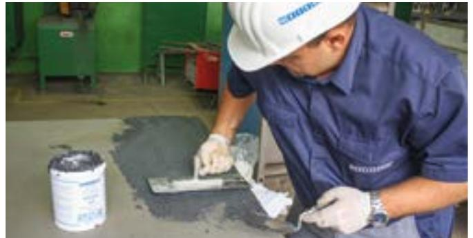
der sofort auf fast allen Oberflächen haftet. Im ausgehärteten Zustand lässt sich das Werkzeugharz mechanisch bearbeiten. Man kann das Material bohren, fräsen, schleifen oder feilen, je nach Bedarf. [www.weicon.de](http://www.weicon.de)
