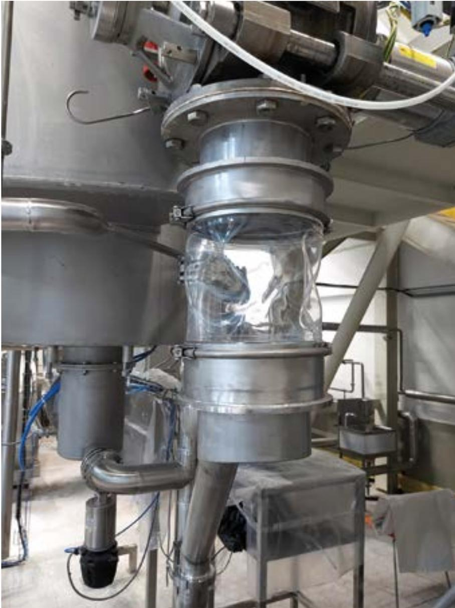
*Manschetten und Kompensatoren als Dichtungslösungen*
