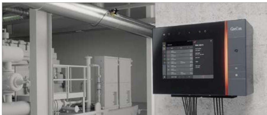
Mission Control: das Herzstück – die neue Funkenmeldezentrale
