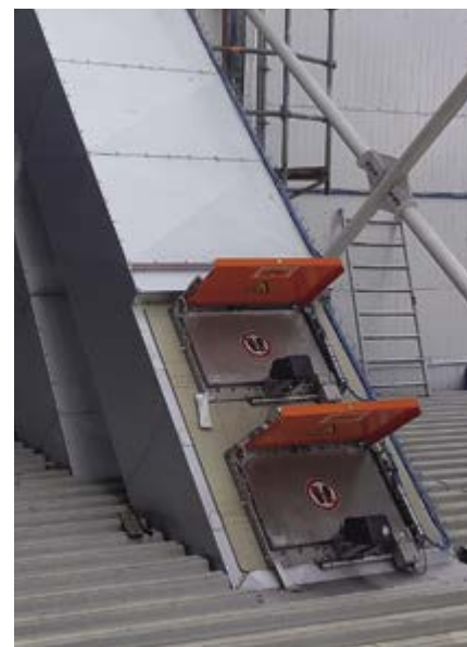
Explosionsschutzklappen sind z. B. für die Druckentlastung an Trocknungssystemen unerlässlich
