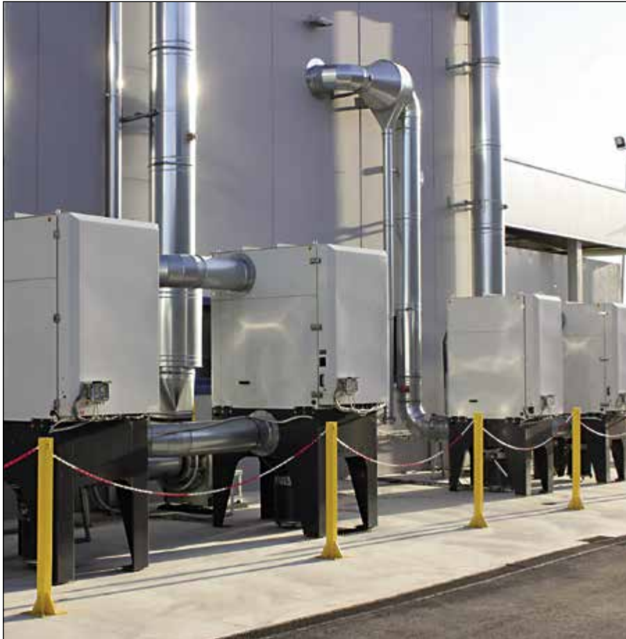
WAMAIR Stand-Alone FPSA polygonaler Staubabscheider
