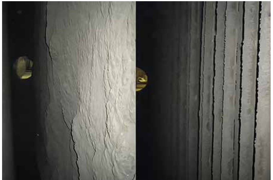
Im Vergleich nach 6 Monaten: Abreinigung mit Fallhammer (links) und mit NHK (rechts)
