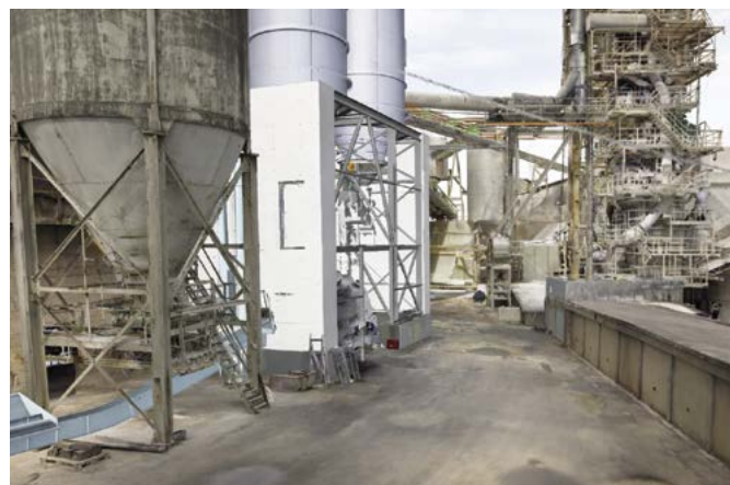
Die Anlagenteile im Zementwerk werden virtuell erkannt
