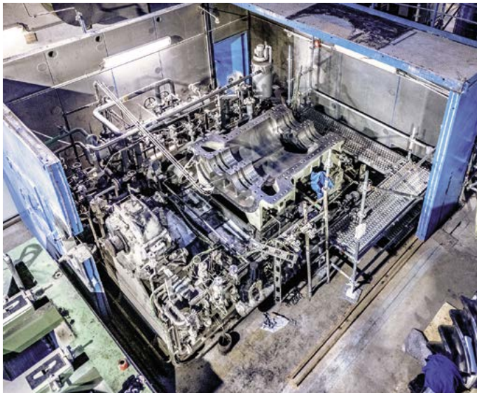
Der VRO836 von AERZEN, einer der größten Prozessgasverdichter der Welt, wurde während der Revision komplett auseinandergebaut
