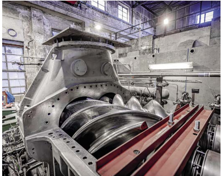
Das Gehäuse mit den beiden Rotoren sitzt wieder an Ort und Stelle im Verdichter
