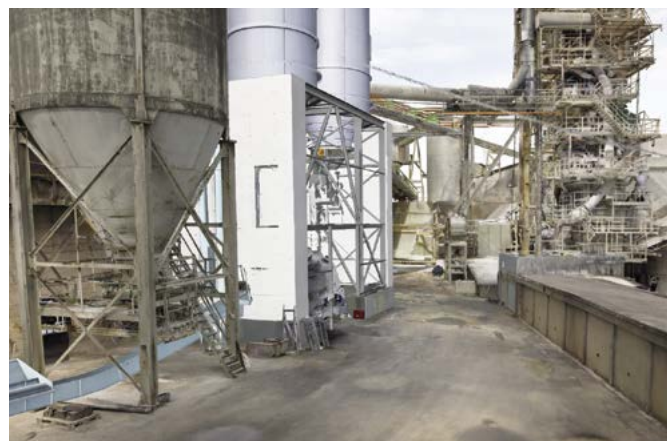
Die Anlagenteile im Zementwerk werden virtuell erkannt
