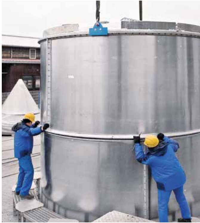
Die Verbindungs- und Montagetechnik von Siloabschnitten reduziert die Kosten für den Langstreckentransport erheblich
