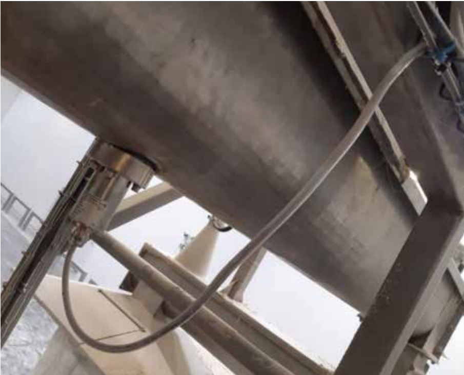
Feuchtemessung mit M-Sens 3 in der Praxis
