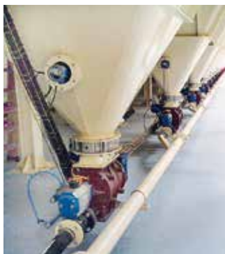
Durchblasschleusen RVS geben das zu fördernde Produkt gleichmäßig in die pneumatische Förderleitung auf
