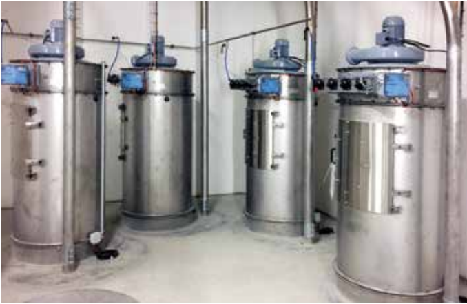
Entlüftungsfiler WAMFLO ATEX scheiden den entstehenden Staub ab und vermeiden so den Austritt in umliegende Bereiche
