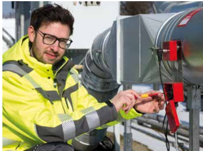
Funkenmelder werden an der entsprechenden Rohrleitung montiert
