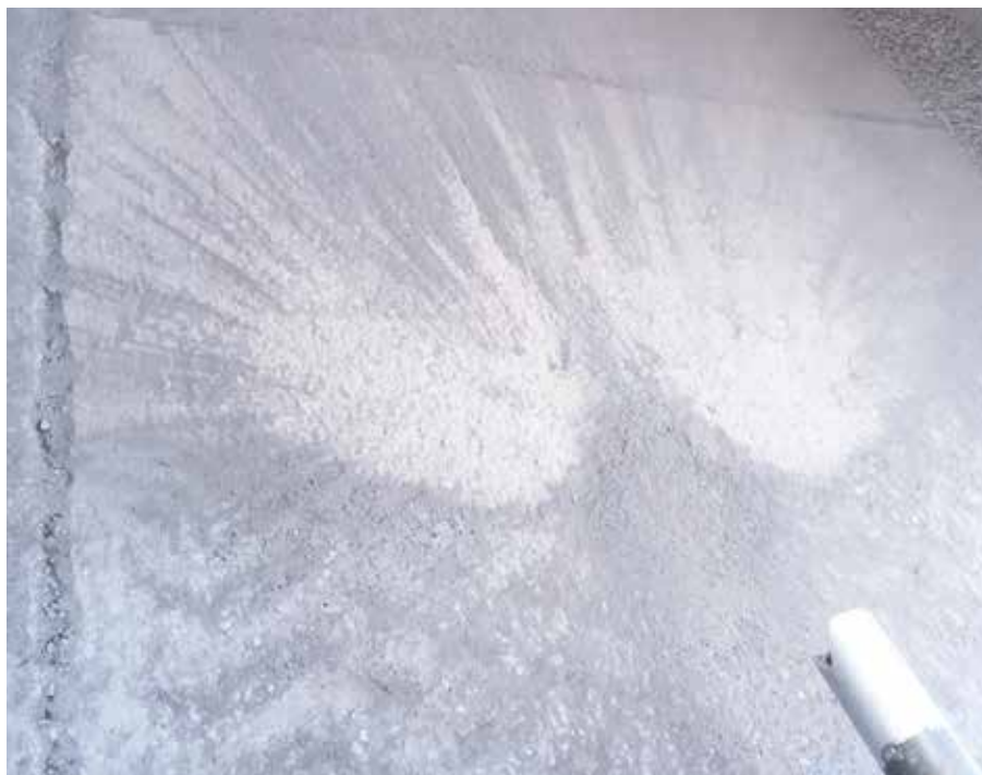
VSR BLASTER® Rapid Change Düse im Einsatz
