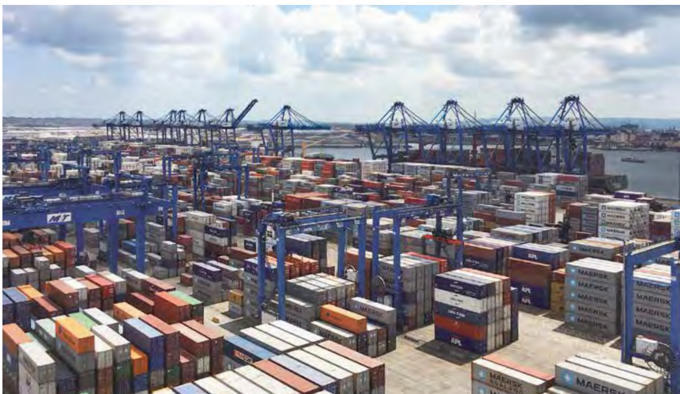
Der Manzanillo International Terminal (MIT) in Panama ist einer der wichtigsten Hafenterminals Lateinamerikas mit Verbindungen in etwa 125 Länder
