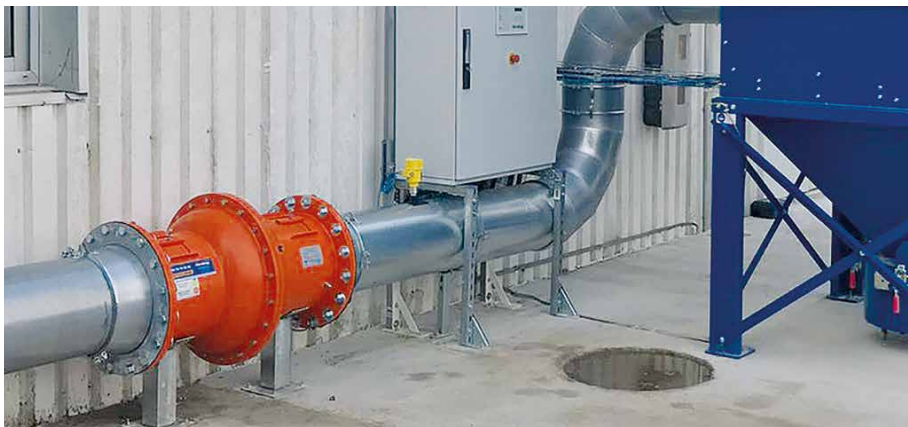
VENTEX® Explosionsschutzventile schützen Rohrleitungen bei Herding France S.A.S.
