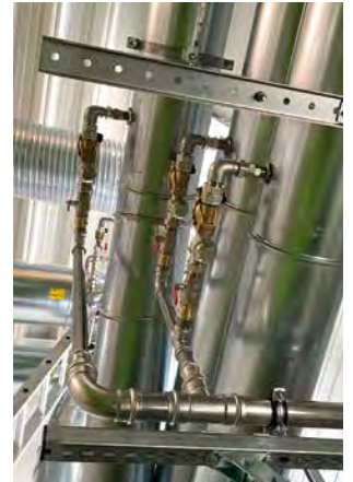
Löschungen in Absaugleitungen
