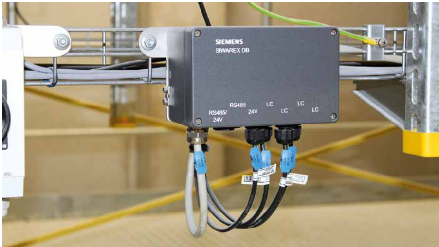
Cleverer Kasten: Siwarex DB sorgt mit Einzelkanalauswertung für zusätzliche Diagnosemöglichkeiten. Fehlermeldungen zu jeder einzelnen Wägezelle werden zentral am Simatic Controller oder dem HMI angezeigt.
