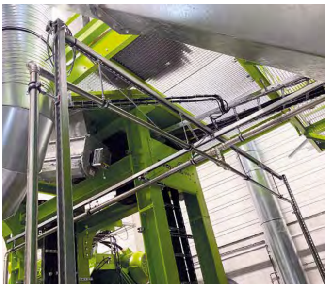
Insgesamt wurden 340 Meter Löschwasserleitung verlegt
