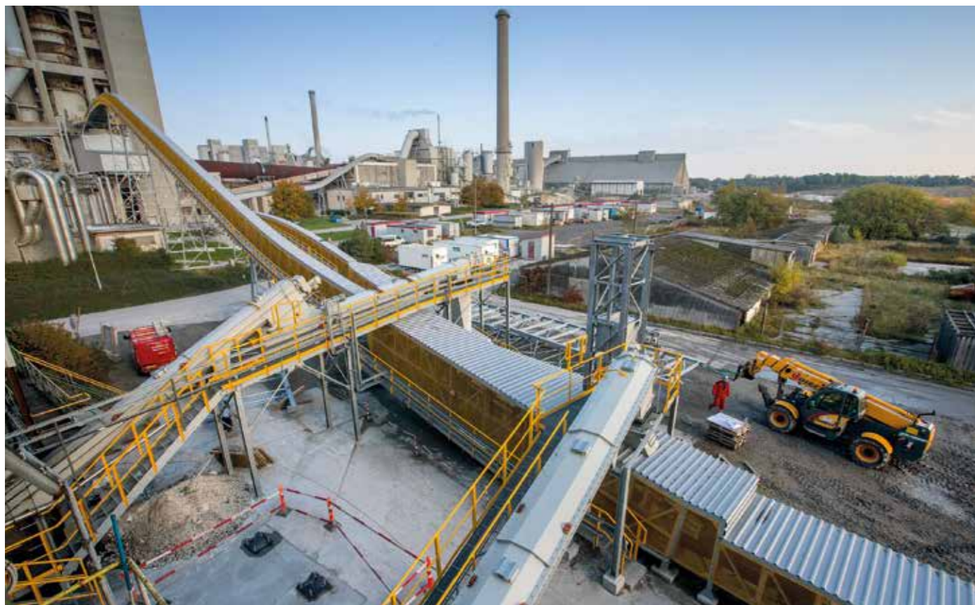
Die BEUMER Group liefert Komplettsysteme, um Kalzinator und Hauptbrenner mit alternativen Brenn- und Rohstoffen zu versorgen. Hauptbestandteil sind die Pipe Conveyor. Beschickt werden diese über Schneckenförderer.
