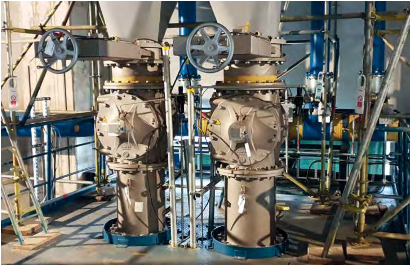
Siloabzug und obere Zellenradschleusen (© RWE Niederlande / FLSmidth Hamburg GmbH)
