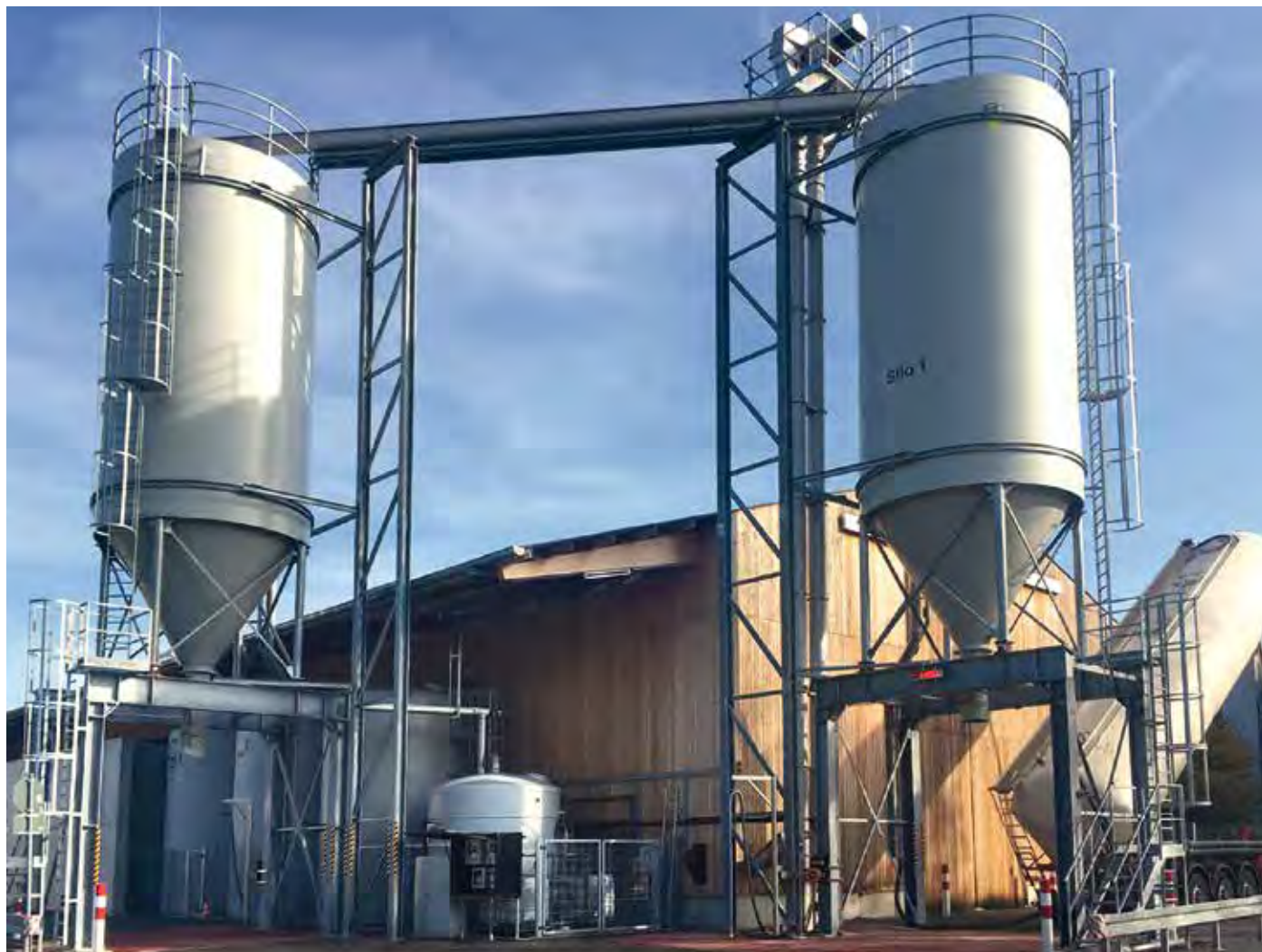
Neues Salzsilo der Stadtreinigung Leipzig mit robusten Wägezellenmodulen vom Typ VC 3500
