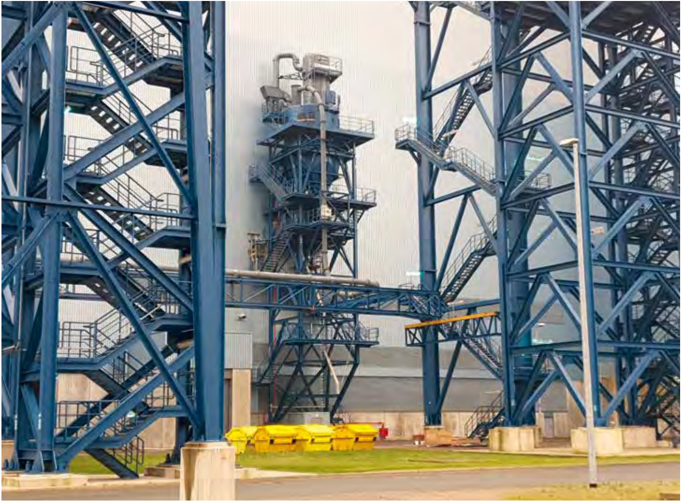
Kesselhaus und Zwischensilo mit Treppenturm (© RWE Niederlande / FLSmidth Hamburg GmbH)
