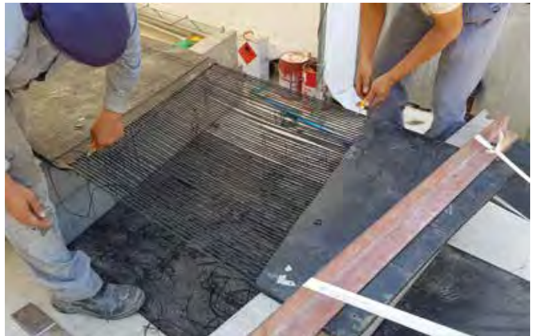
Das sogenannte „Flaking“: Die einzelnen Gurtlagen werden zu einem Gurtstapel mit einer Länge von knapp 7.000 Metern aufgestapelt, die Service-Techniker bereiten den Gurt vor, um die Bandenden verbinden zu können
