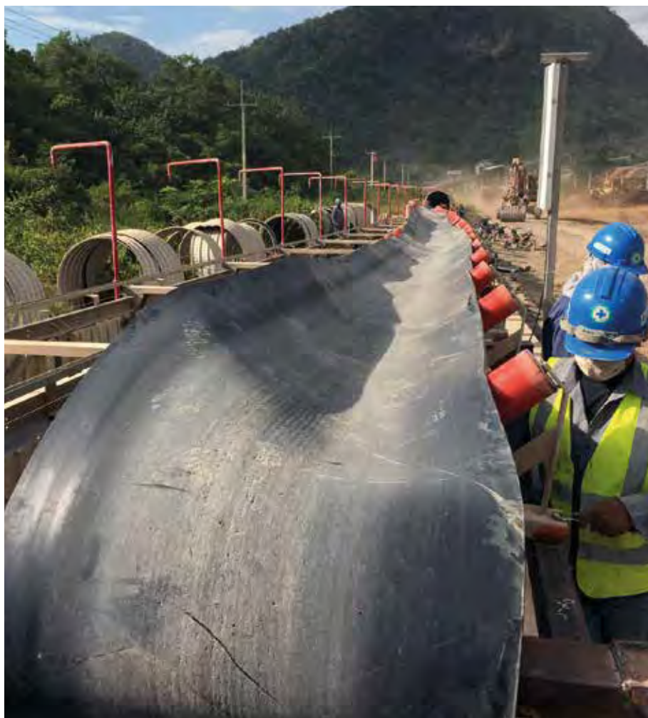
Nach rund vier Jahren musste bei dem knapp 3,5 Kilometer langen Overland-Conveyer der alte Gurt schnell und effizient getauscht werden
