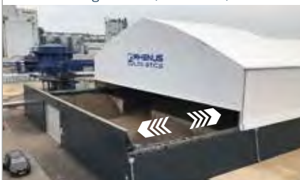
Sonderbauten (z.B. Verschiebbare Dachkonstruktion)
