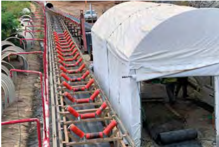
Der neue Gurt lagert neben der Förderanlage, die einzelnen Gurtwickel wurden neben der Förderanlage zu einem langen Gurt zusammengelegt und mit dem alten Gurt verbunden
