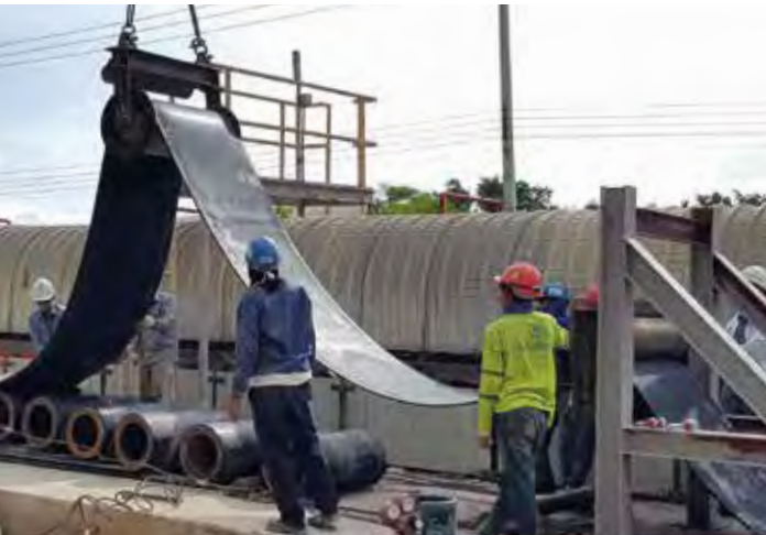
Das sogenannte „Flaking“: Die einzelnen Gurtlagen werden zu einem Gurtstapel mit einer Länge von knapp 7.000 Metern aufgestapelt, die Service-Techniker bereiten den Gurt vor, um die Bandenden verbinden zu können
