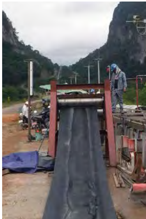
Das neue Band wird in einem Rutsch in die Anlage hinein und der alte Gurt herausgezogen
