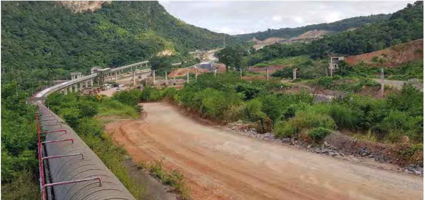
Der thailändische Zementhersteller TPI beauftragte die BEUMER Group 2013 mit der Montage einer komplexen Förderanlage, um Kalkstein vom Steinbruch zum Mischbett zu transportieren (Bildnachweis: BEUMER Group GmbH & Co. KG)
