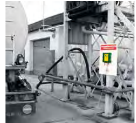
Erdungsüberwachung mit LKW-Erkennung mittels FARADO
