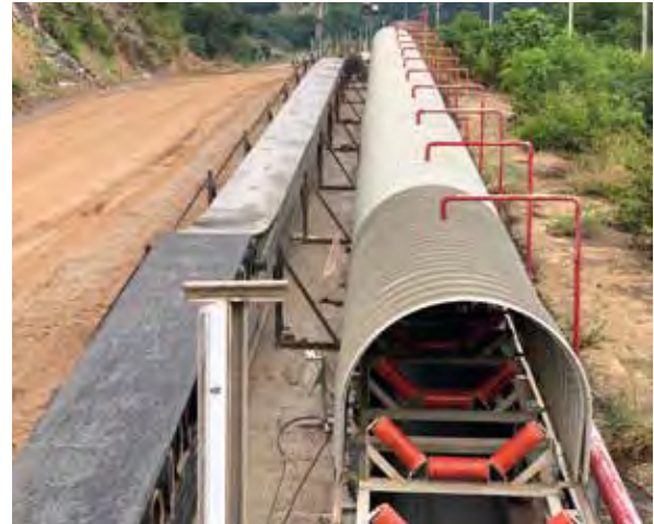
Der neue Gurt lagert neben der Förderanlage, die einzelnen Gurtwickel wurden neben der Förderanlage zu einem langen Gurt zusammengelegt und mit dem alten Gurt verbunden
