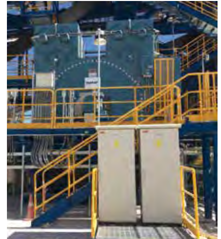
5 MW-Antrieb nach der Montage (Quelle: TAKRAF)
