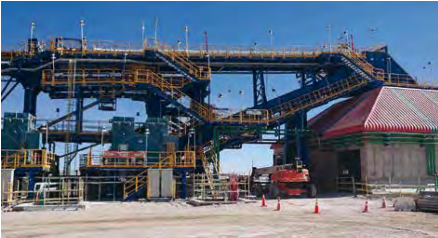
Bunkergebäude mit Gutabwurf des Overland Conveyor OLC-01 (Quelle: TAKRAF)
