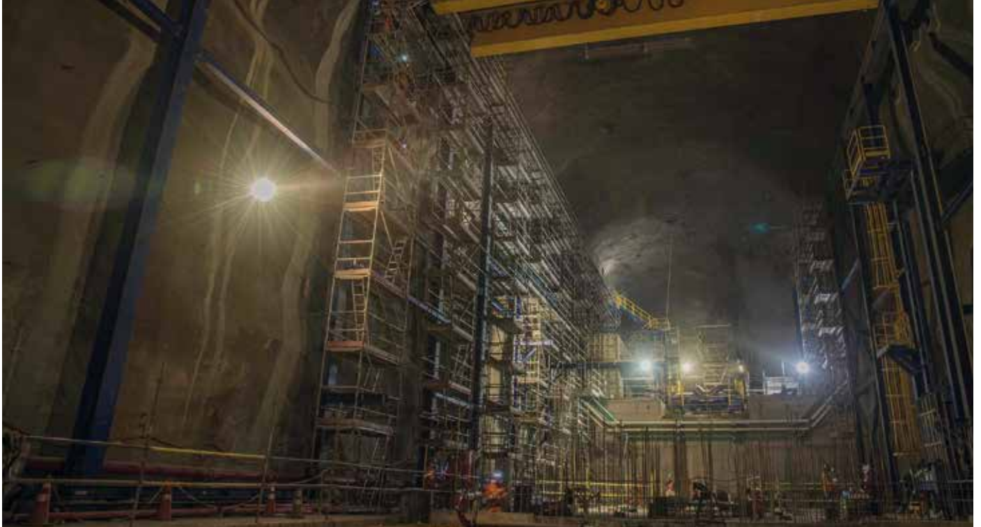
Untertage-Übergabestelle während der Bauphase (Quelle: TAKRAF)
