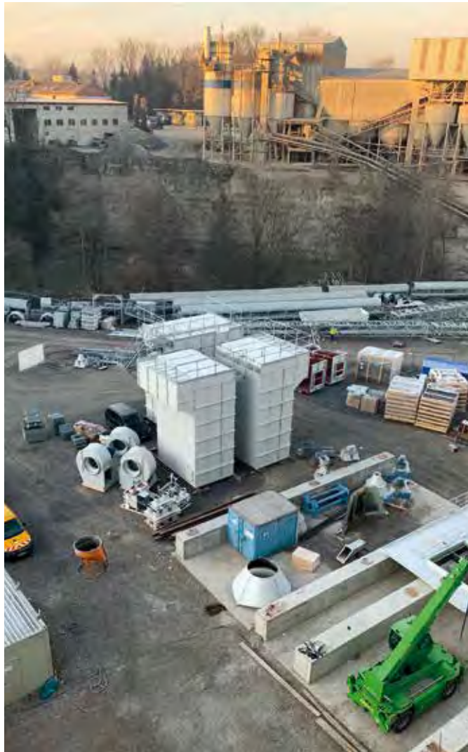
Montagevorplatz für Filtergehäuse und Staubsilo, zu sehen die 3 Filtergehäuse die später auf den 2 Silos montiert werden und zu 2 St. Filtern werden
