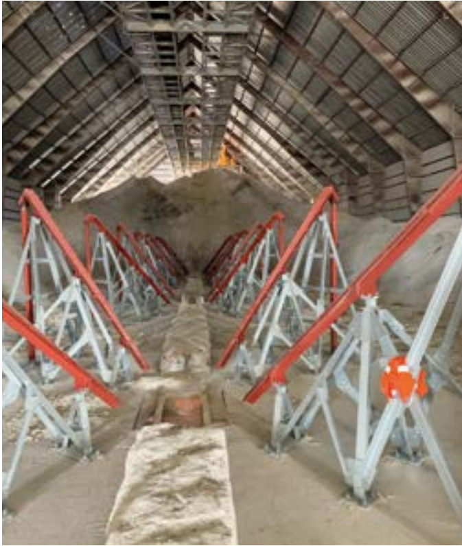
VSR BLASTER-Luftkanonen, fertig montiert
