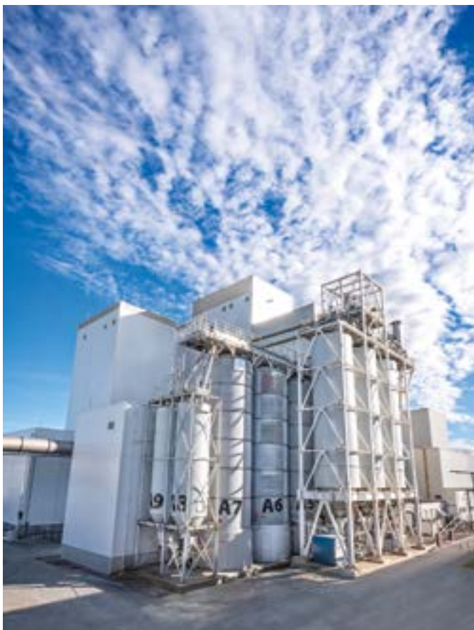
Großkomponenten-Silos im Außenbereich
