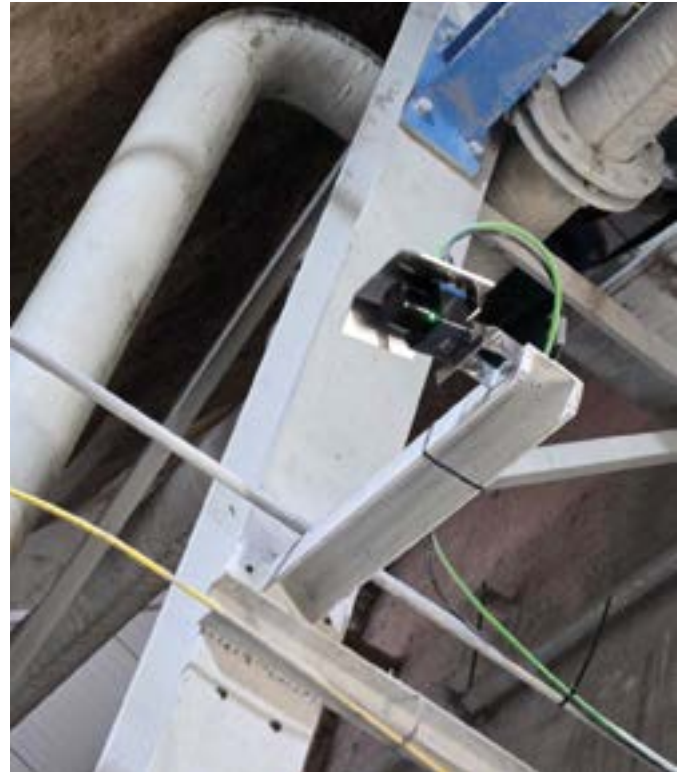
Owl Eye LiDAR-Sensor zum Erfassen von Schüttgut
