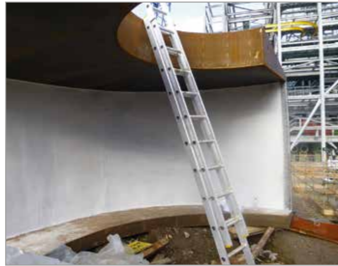
Verschleißfeste Auskleidung eines Zykloneinlaufes
