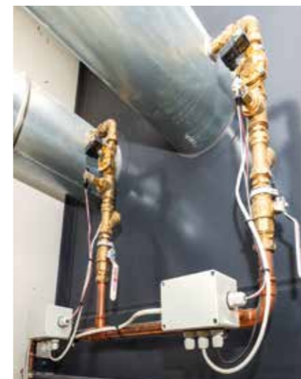
Unschlagmäßiger Einbau und falsche Positionierung können die Detektion deutlich schlechter ausfallen lassen als bei einer optimalen Lösung
