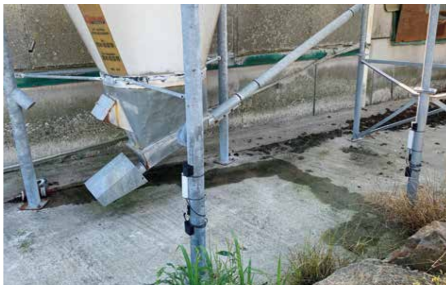
Die IoT-Sensoren zur Digitalisierung von Silofüllständen von Nanolike können über Jahre hinweg wartungsfrei mit Batterien betrieben werden. Es müssen also keine Kabel verlegt werden.
