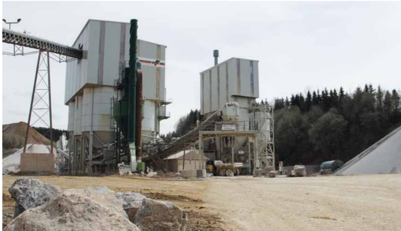
Anlage der Briloner Hartstein Werk GmbH, ein Unternehmen für hochwertige Kalkprodukte im Industrie- und Futtermittelbereich
