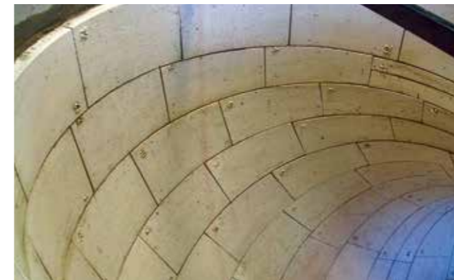
Formstückauskleidung mit Zirkonoxid-Keramik
