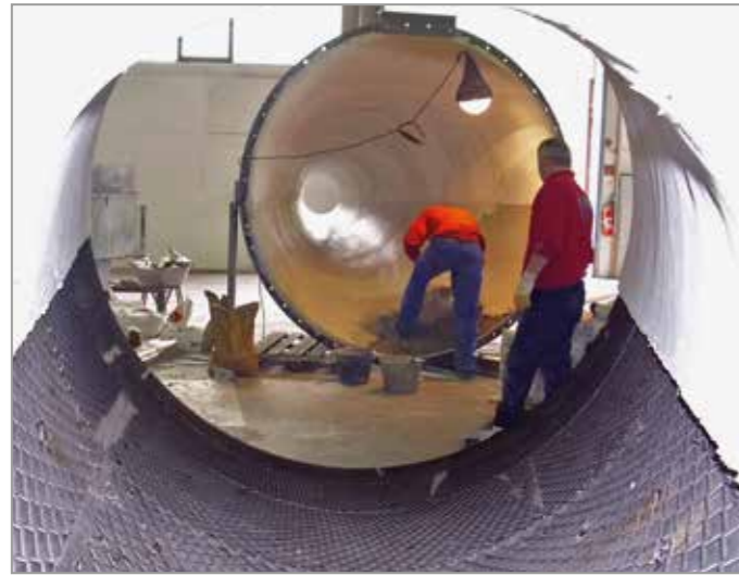
Wellgitter vor Auftrag des SC-WeatStop®-Mörtels
