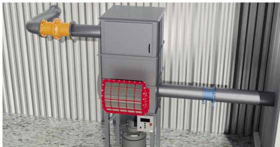
Bild 2: Passiv geschützter Filter mit passiver Entkopplung
