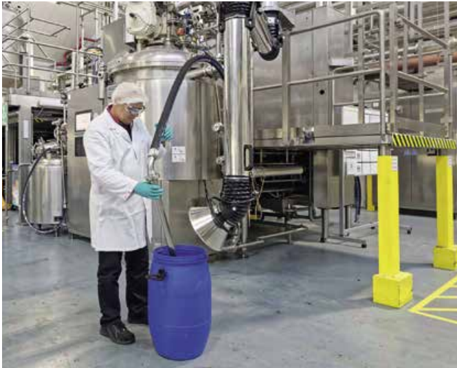
Bild 3: Hier schaffen die Saugarme der Absauganlage die Voraussetzung für ein staubfreies Eindosieren von pulverförmigen Inhaltsstoffen für Hautpflegeprodukte in die Mischanlagen
