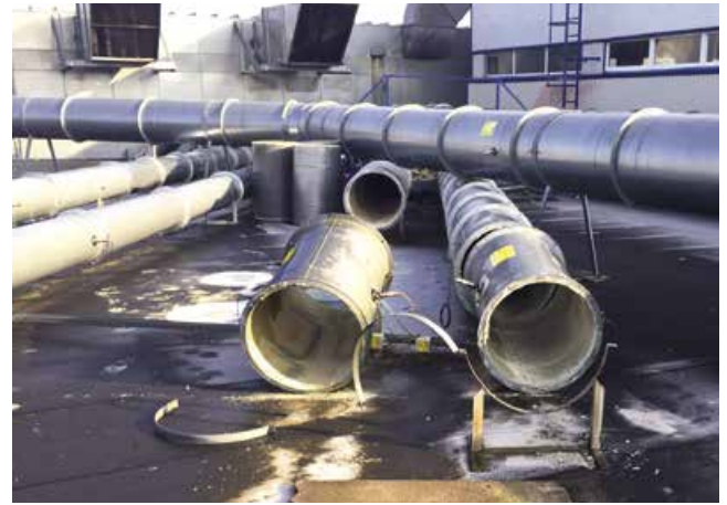
Bild 1: Typische Ablagerungen innerhalb einer Transportleitung. Deutlich ist zu erkennen, dass die Ablagerungen sich nicht nur im unteren Bereich, sondern überall an der Wandung befinden.
