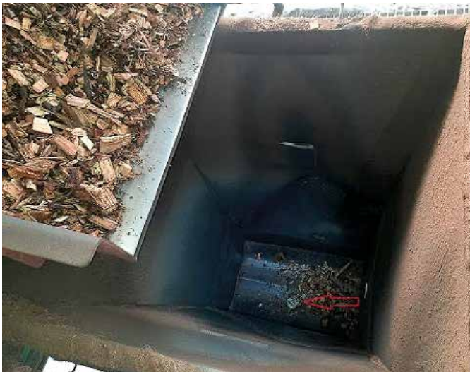
Sensor im Trichter vor dem Wiegeband für Holzhackschnitzel
