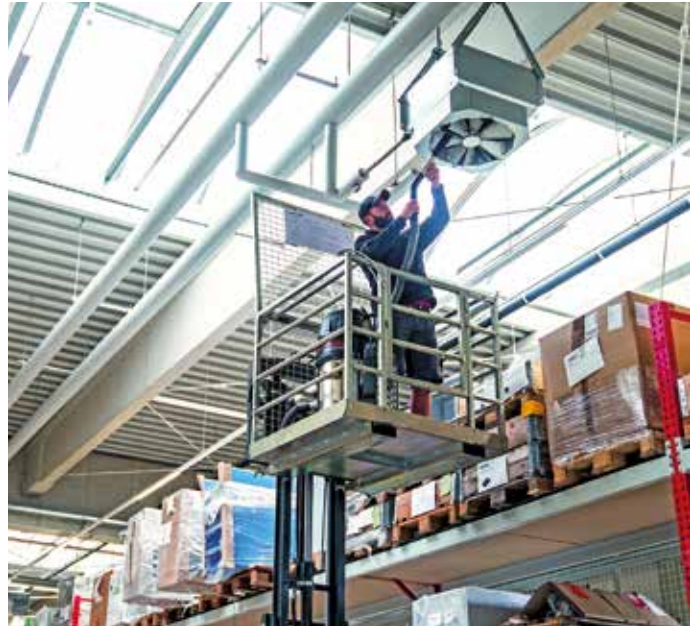
Bild 3: Eine weitere praxisgerechte Anwendung sind Arbeiten in der Höhe, z. B. auf Hubarbeitsbühnen
