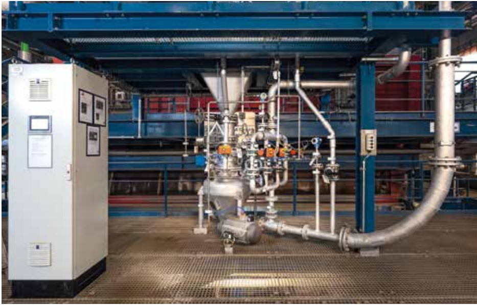
Druckgefäß und PLC nach Montage
