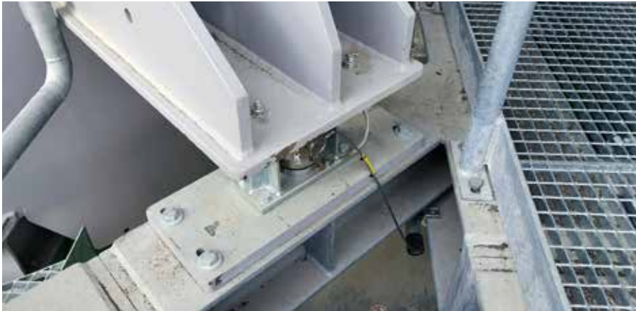
Abbildung 3 – Wägezelle mit mechanischem Montagemodul zur optimalen Krafteinleitung
