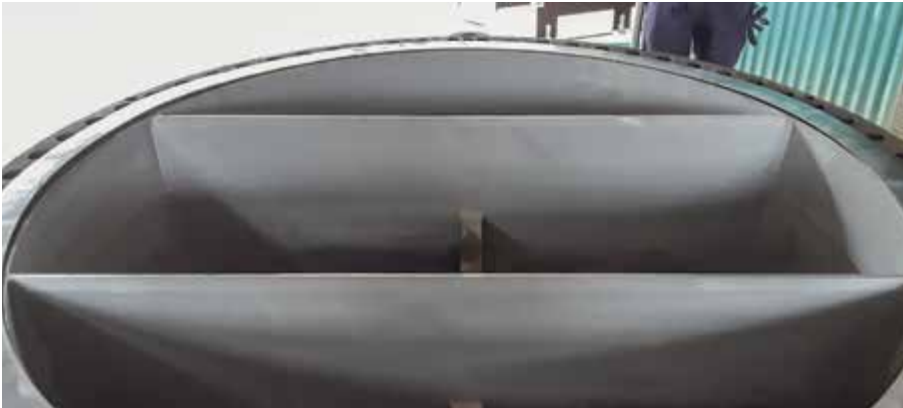
Castolin XupersoniClad auf rohrförmigem Wärmetauscher in chemischem Werk aufgebracht
