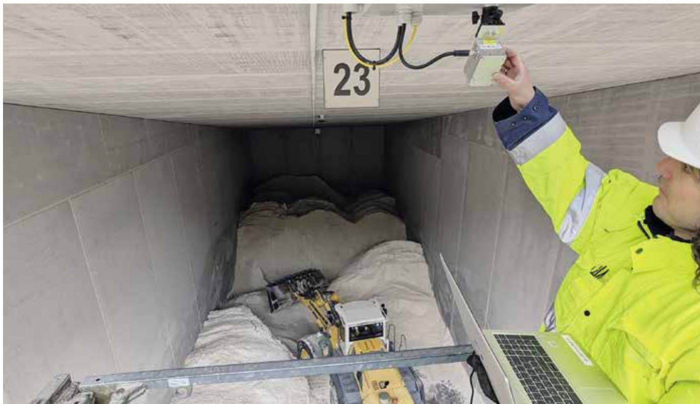
Inbetriebnahme einer Owl Eye-Anlage
