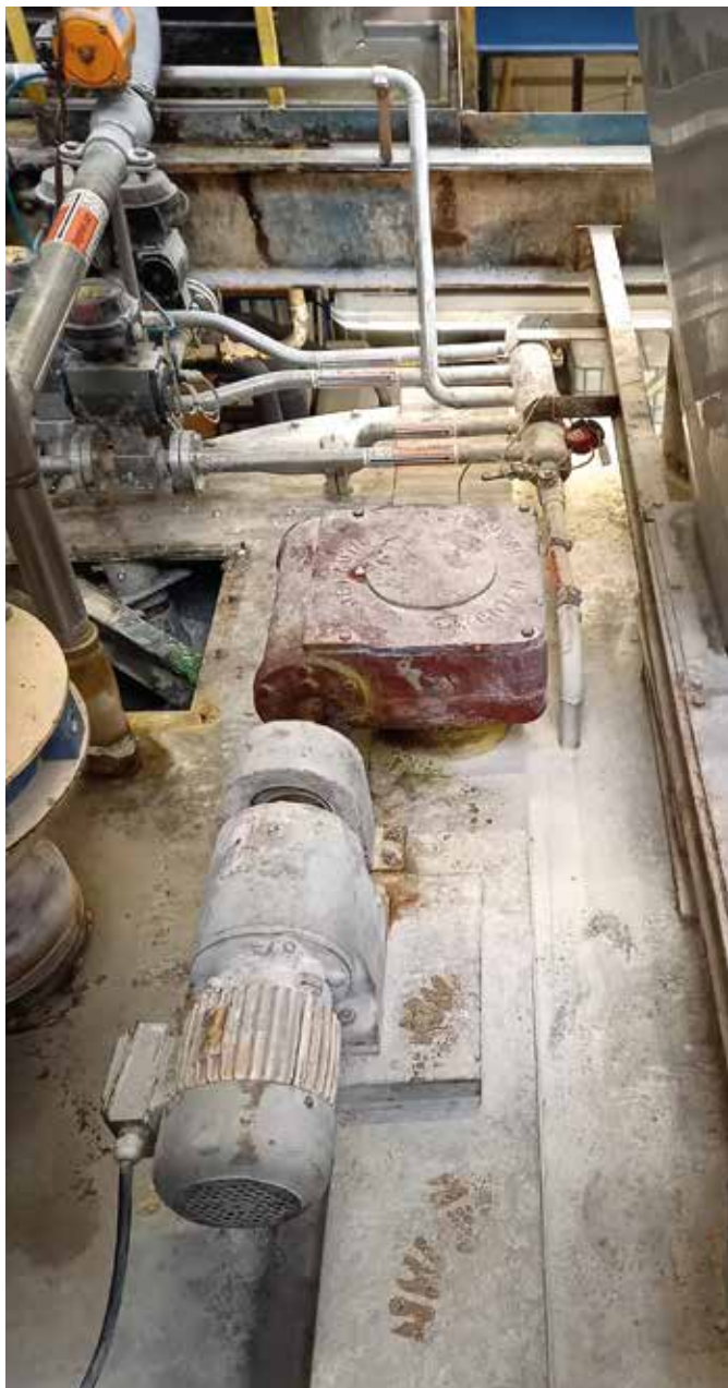
Die Situation der Mischer vor dem Umbau
