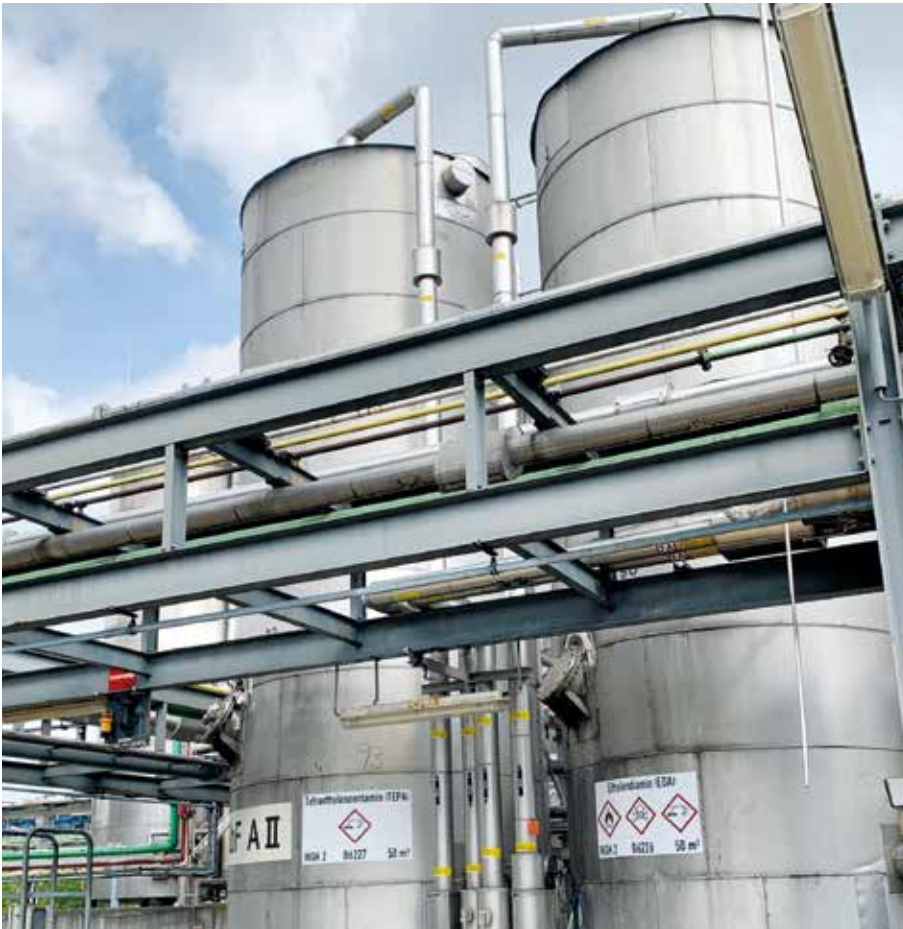
Flachbodentanks kommen bspw. in der chemischen Industrie zum Einsatz. (Bildquelle TÜV SÜD)
