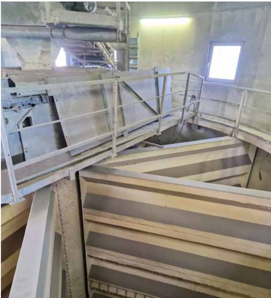
Fertiggestellte Silokammer mit REMAPUR-75
