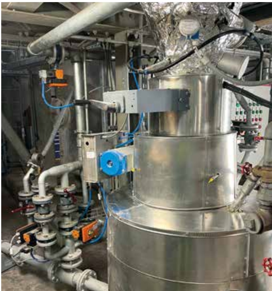
Isoliertes Druckgefäß mit geregelter Luftverteilung
