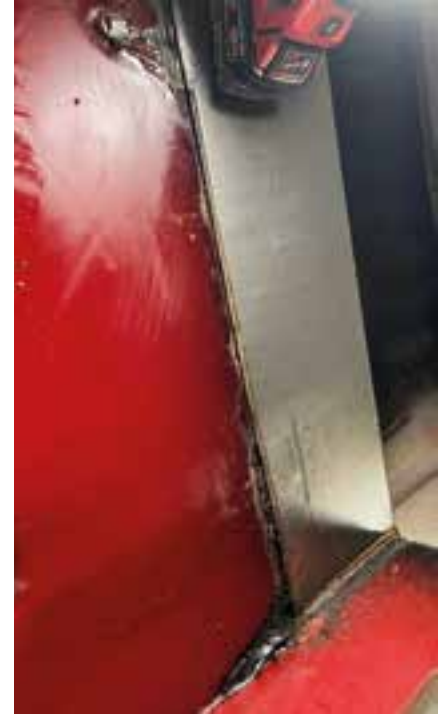
Reparatur mit Pucest TIX, dem spachtelbaren Verschleißschutz
