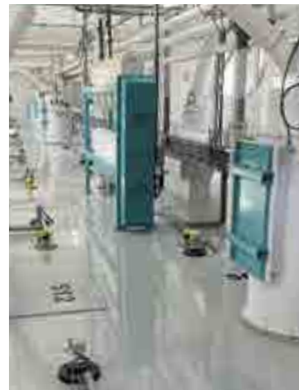
80 GHz-Radarsensoren VEGAPULS messen auf den Silos hochpräzise ohne Kontakt zum Medium, ideal für Hygieneanwendungen
