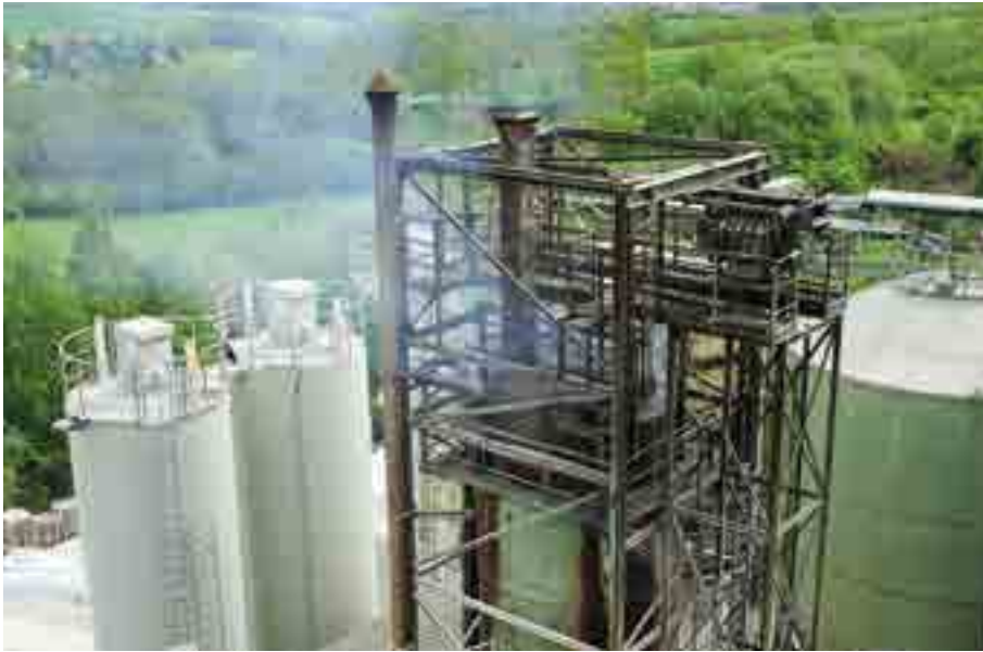
Beim alten Brennofen war der Verbrauch an elektrischer Energie nicht so dominierend
