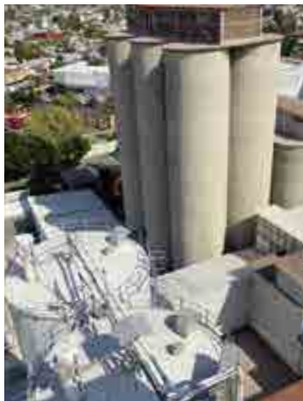
80 GHz-Radarsensoren VEGAPULS messen auf den Silos hochpräzise ohne Kontakt zum Medium, ideal für Hygieneanwendungen
