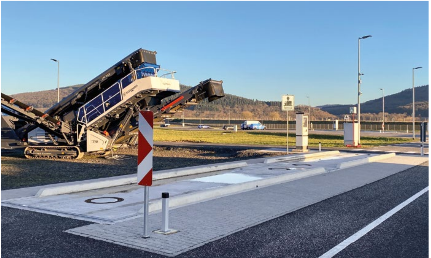
Die Lkw-Verwiegung von Recycling-Schüttgütern entwickelt sich zunehmend zu einem digitalen Prozess
