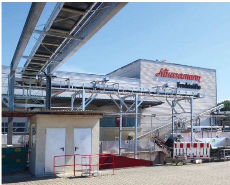
Die neue Förderanlage des schwäbischen Fruchtsaftherstellers Haussermann von Apullma automatisiert die Annahme, Entlaubung und Sortierung von Streuobst
