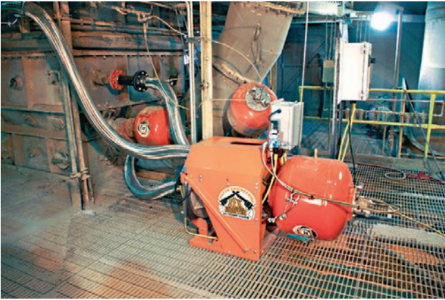
Bild 12: Manche Luftkanonensysteme versorgen mehrere Düsen mit der Luft aus einem Reservoir
