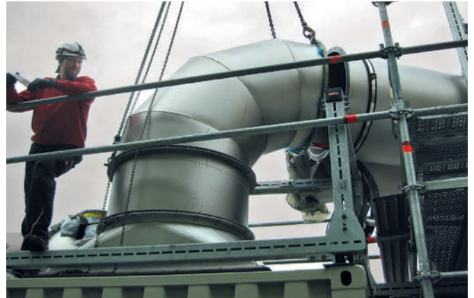
Endmontage des Fortluftstrangs mit einem Rohrbogen in 90° und einem Durchmesser von 1000
