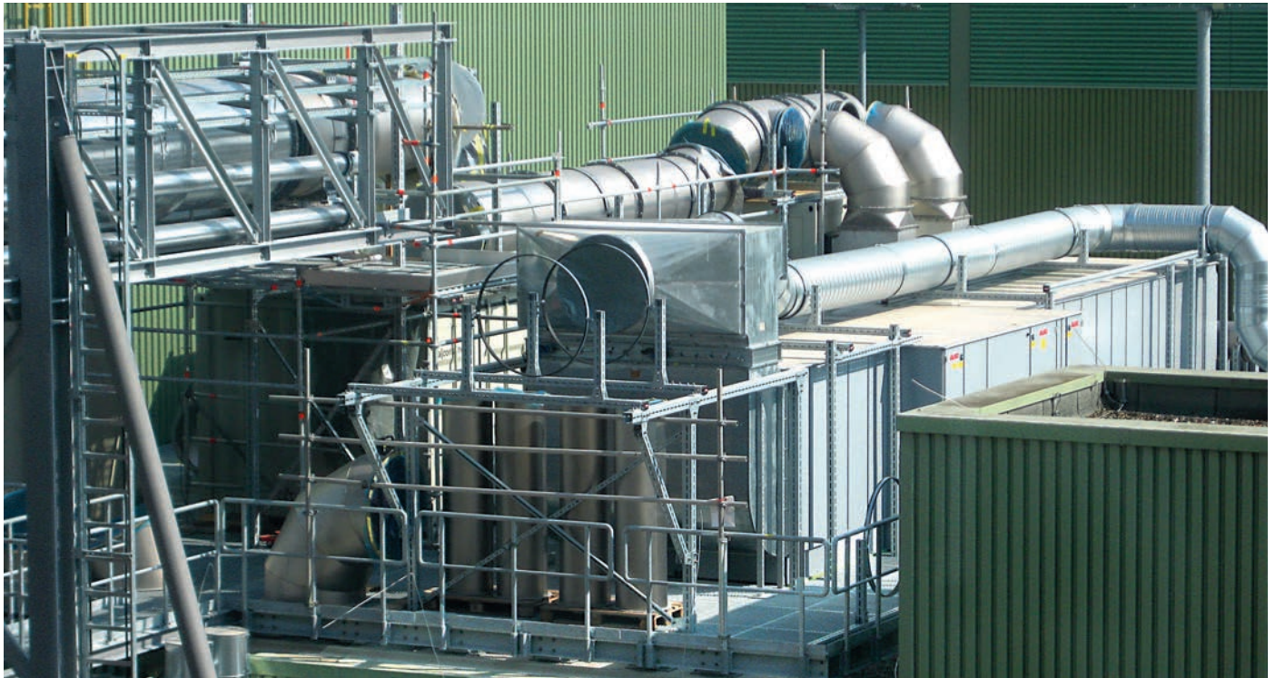
Dachaufbau von Jacob Rohre beim Rückbau im Kernkraftwerk Grafenrheinfeld für konditionierte Zuluft und Abluft.
