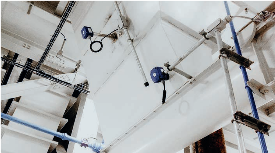
Niedrige Schüttgewichte erfordern hier eine hohe Sensibilität des Sensors. Unabdingbar sind staubdichte Gehäuse sowie die Umsetzung vieler Schaltzyklen bei schnellerem Durchfluss.
