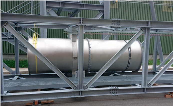
Bestückung der Rohrbrücke mit Rohrschüssen in der Dimension DN1250 mittels modularem Schienensystem
