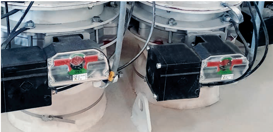
Drehklappe mit pneumatischem Antrieb
