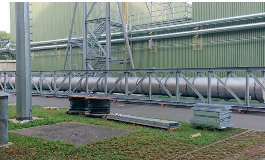
Fertig bestückte Rohrbrücke mit 16 Rohrschüssen mit einer Gesamtlänge von 32 Meter
