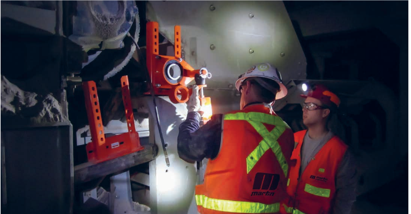
Zwei Techniker stellen die Vorspannung eines Gurtabstreifers ein, um eine optimale Reinigungsleistung sicherzustellen
