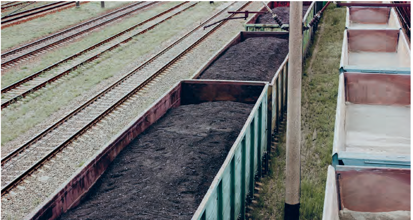
Anwendungsschema: Radar-Füllstandmessung der Kohle im Betontrichter bei der Waggonentladung in einen darunterliegenden Bunker
