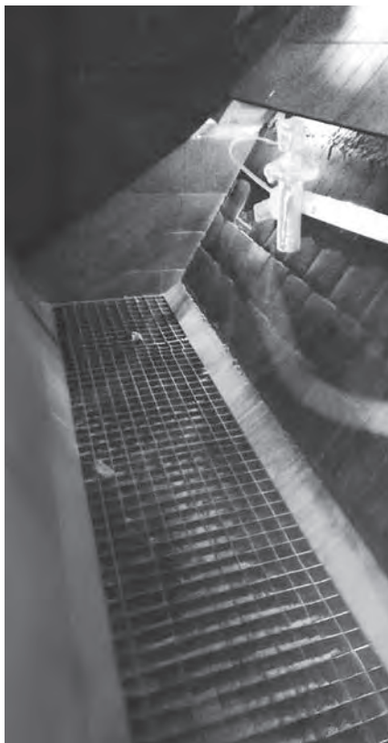
Individuell angepasste Radar-Füllstandmessung mit Staubrohr, Luftspülung, Schutzdach und intelligenter Störsignalausblendung
