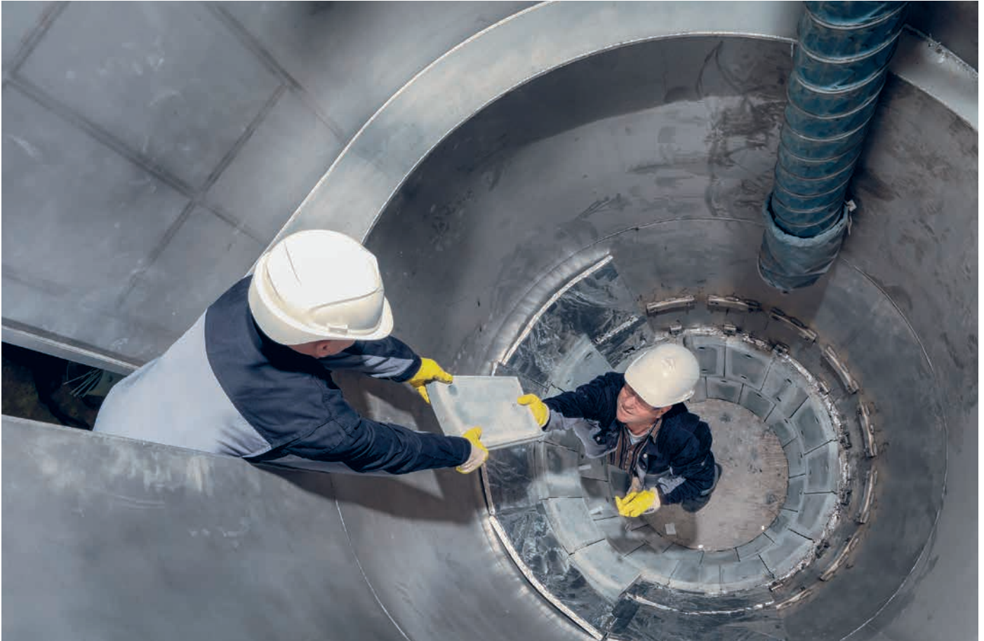
Auskleidung an einem großen Zyklon
