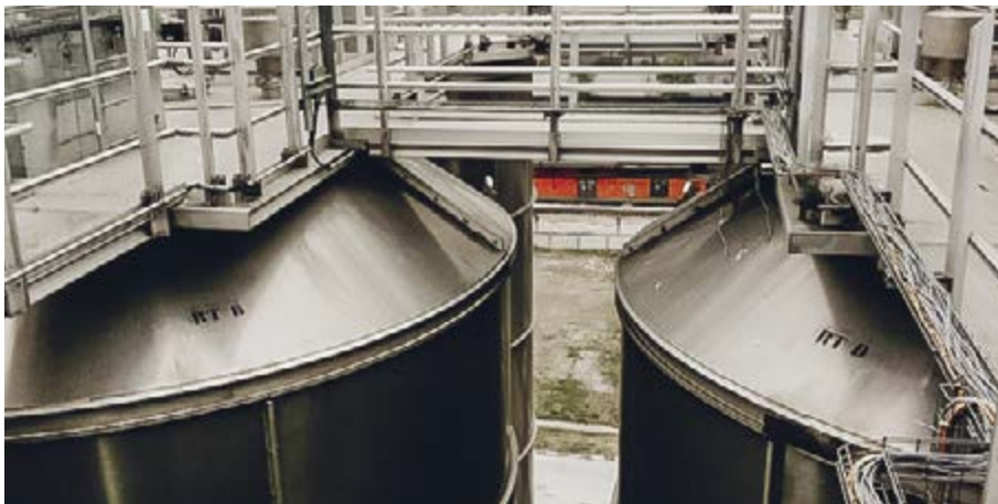
UWT-Applikation an einem PVC-Staub-Silo
