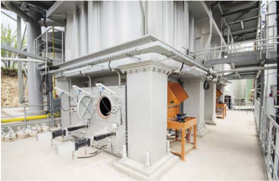
GGR-Ofen mit Zugängen zum Ofenaustrag
