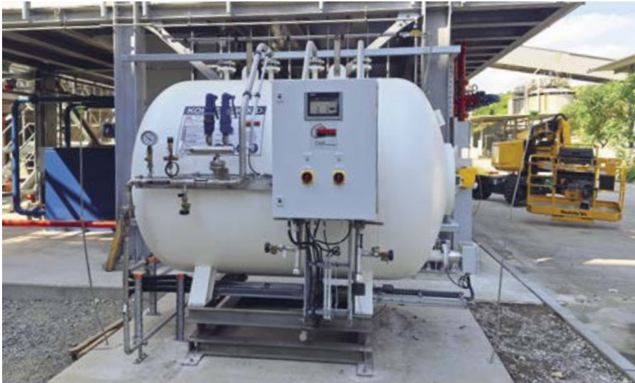
Bild1: CO 2 -Bevorratung im Tank
