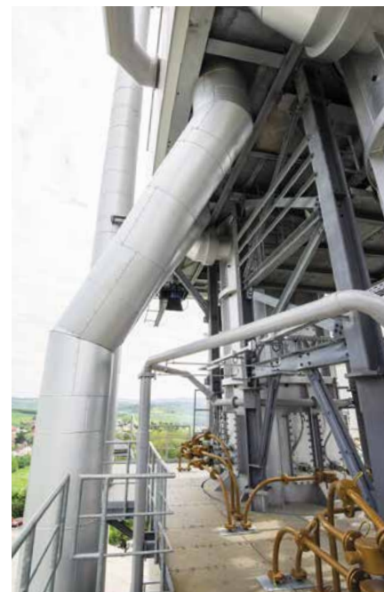
Die Dimension der Rohrleitungen lässt erahnen, wie hoch der Bedarf an Prozessluft in GGR-Öfen ist
