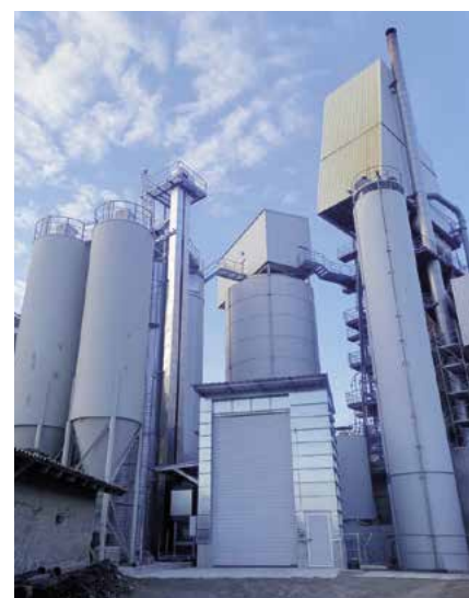
Köhler Kalk hat den Gleichstrom-Gegenstrom-Regenerativofen (GGR) im Jahr 2017 in Betrieb genommen – und war damit das erste Unternehmen in Deutschland, das Dolomit im GGR-Verfahren Dolomit brennt (Bild: Köhler Kalk GmbH)
