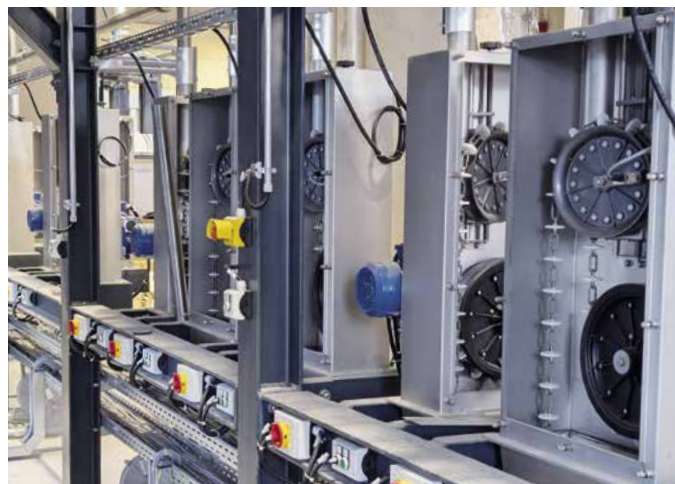
Mit der Entscheidung für die Rohrkettenförderer ist man bei Vogt Plastic sehr zufrieden
