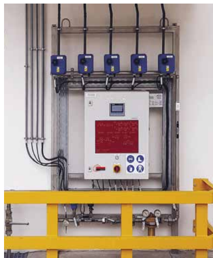
Bild 3: Gasanalysensysteme erkennen rechtzeitig Gefahrensituationen
