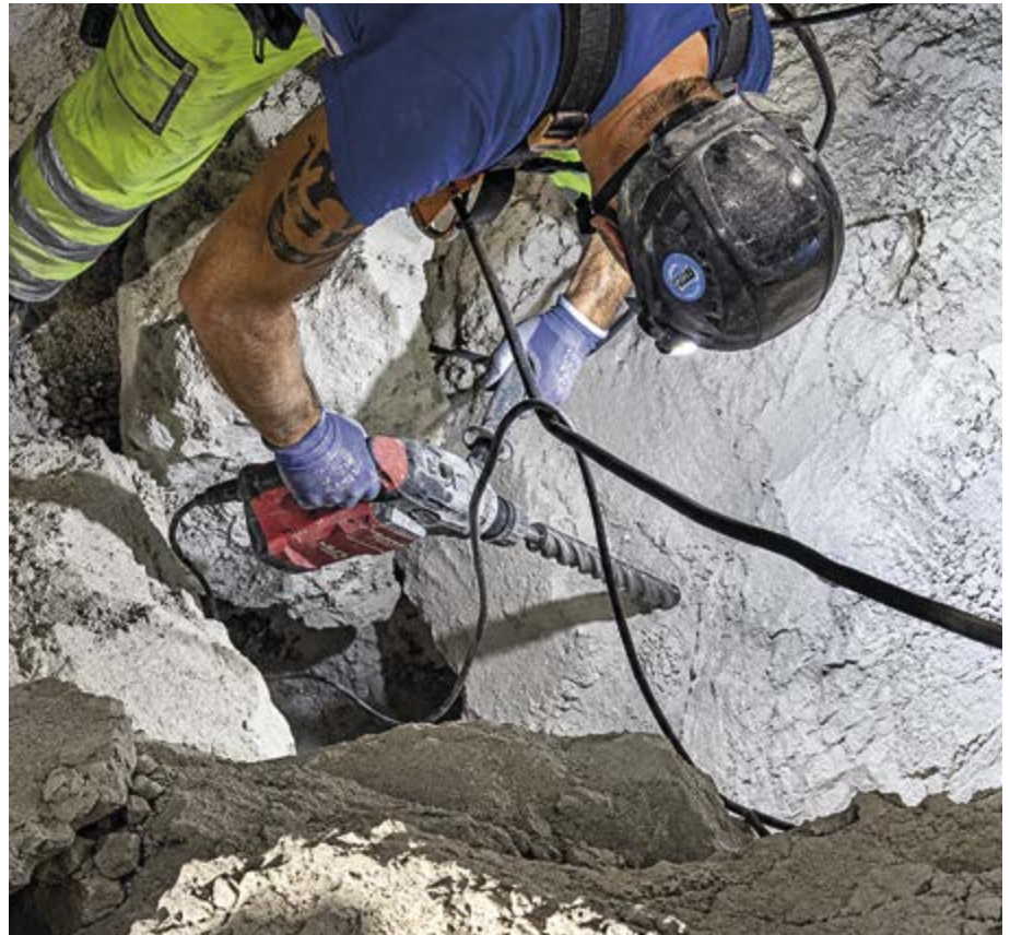
Vorbereitung der Sprengung
