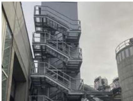
Neuer Turm für das Ausdehnungssystem
