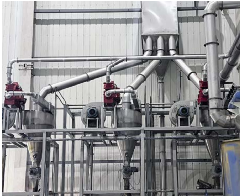
Installiertes Brandschutzsystem bei Luckin Coffee
