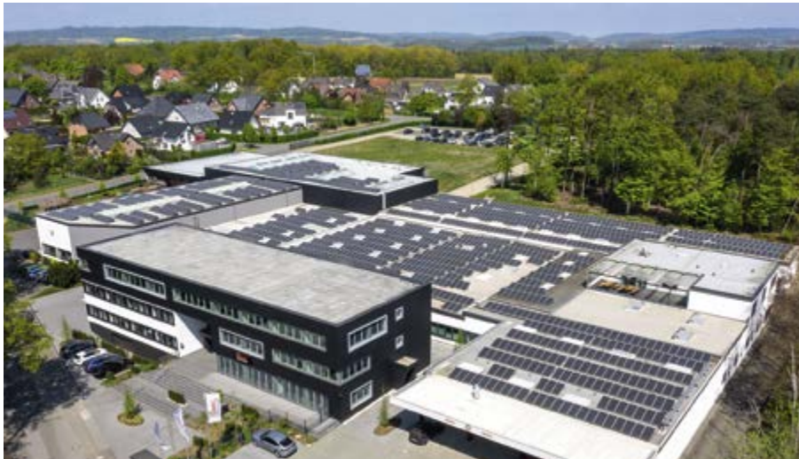
Großzügig: Verwaltung und Produktion von RUWAC in Melle
