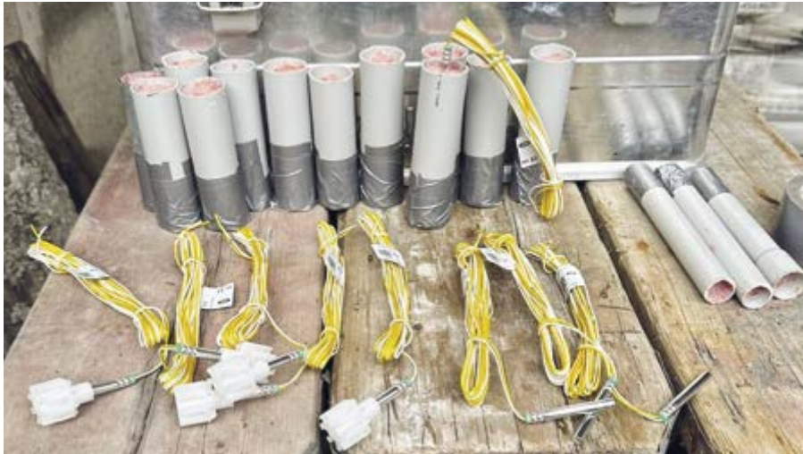
Fertige Sprengladungen vor dem Einsatz im Silo
